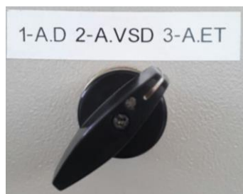
Figura 70: SEL_4 en la posición de arranque estrella-triángulo.
