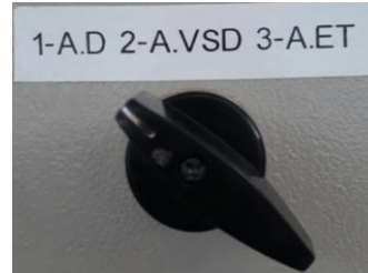
Figura 66: SEL_4 en la posición de arranque directo.
