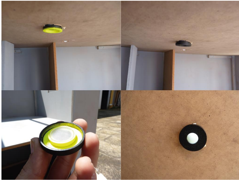
Ilustración 74. Ensamblaje e instalación del difusor. Fuente: Autora.
