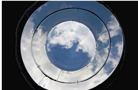
Ilustración 16. Tubo de luz. (Lightway s.r.o., 2014)
