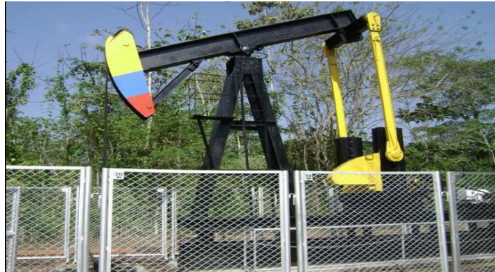
Figura 4. Pozos de campo Casabe con producción mediante bombeo mecánico
