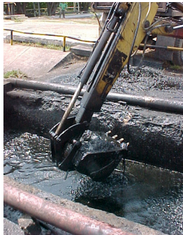
Fotos 17 y 18. Retiro de lodos del canal de llegada
