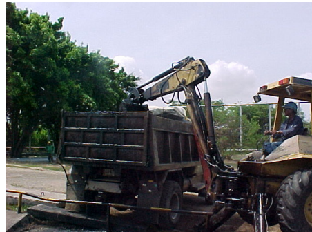
Fotos 17 y 18. Retiro de lodos del canal de llegada
