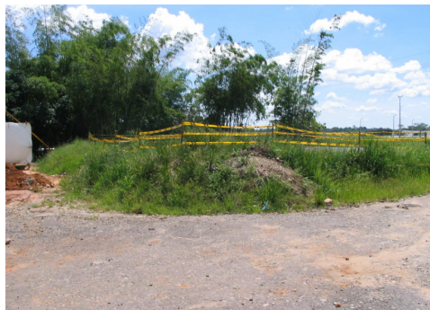
Foto 2. Vista lateral de piscina de borras en la Estación 2. Perfil con talud
