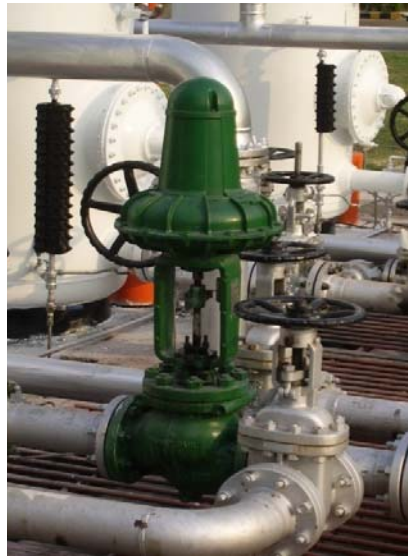
Figura 33. Válvula neumática tipo globo.
