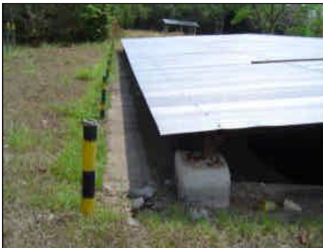
FOTO 14. PISCINA PARA LIXIVIADOS
