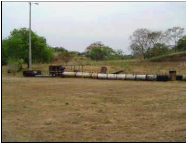
FOTO 42 CHIMENEA, CICLONES, MULTICLONES
