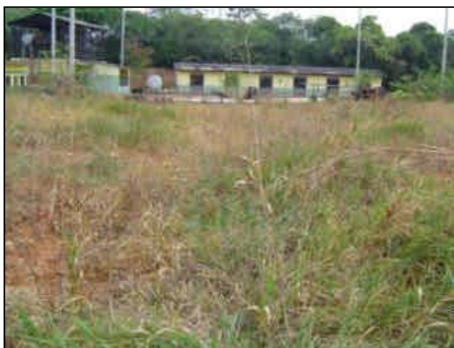
FOTO 4. COBERTURA FINAL Y CASETAS DE RECICLAJE
