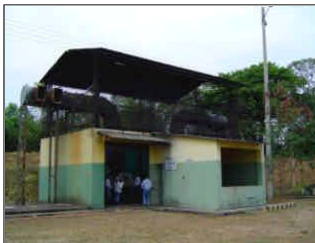
FOTO 37 ÁREA DE INCINERACIÓN
