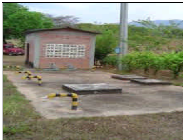
FOTO 10. SISTEMA DE RECIRCULACIÓN DE LIXIVIADOS Y TANQUE DE DISPOSICIÓN DE CENIZAS.
