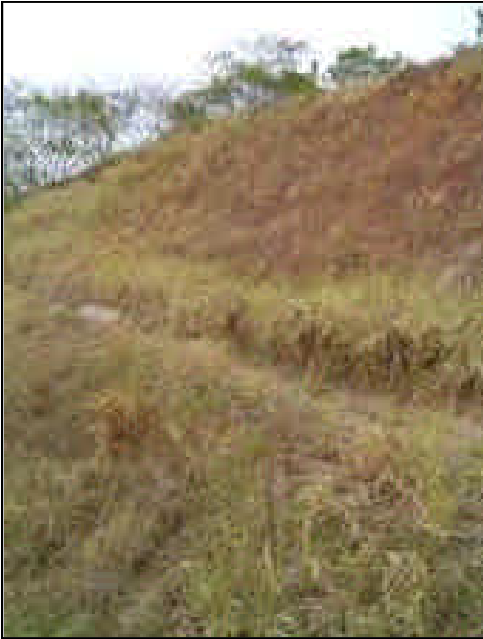
FOTO 28 TALUD DEL RELLENO SANITARIO
