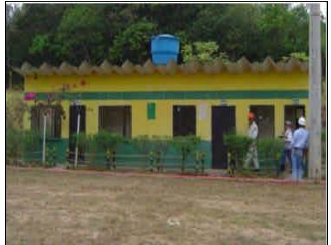
FOTO 29 OFICINAS Y BAÑOS
