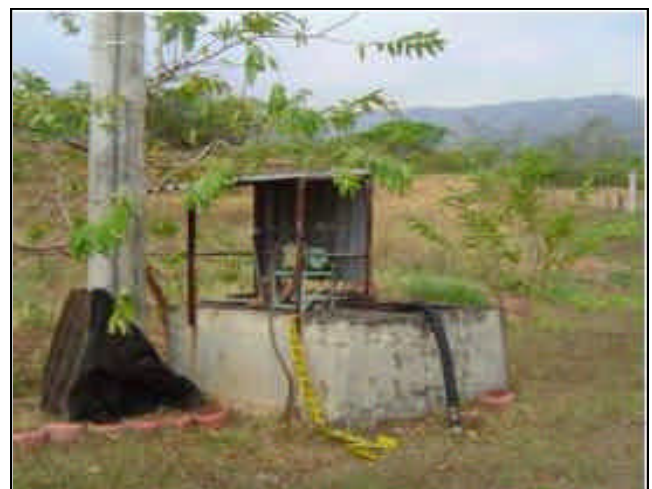
FOTO 25 SISTEMA DE ABATIMIENTO DE AGUAS SUBTERRÁNEAS
