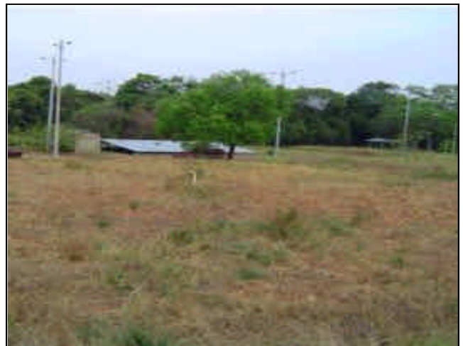
FOTO 57 PANORAMICA DEL RELLENO
