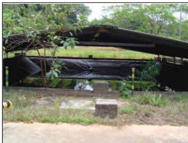
FOTO 11. PISCINA PARA LIXIVIADOS.
