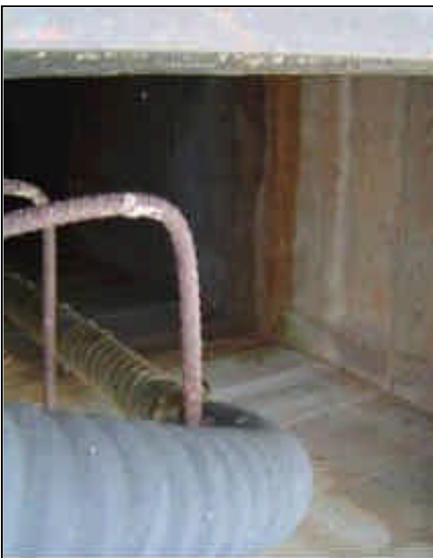
FOTO 26 SISTEMA DE ABATIMIENTO DE AGUA SUBTERRÁNEA
