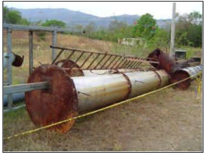
FOTO 43 CHIMENEA DEL INCINERADOR.
