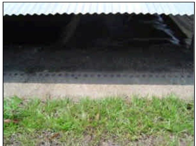
FOTO 15. PISCINA PARA LIXIVIADOS
