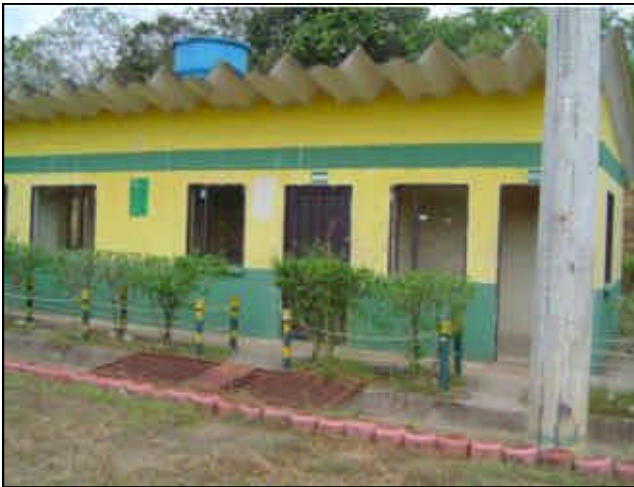
FOTO 30 OFICINAS Y BAÑOS.
