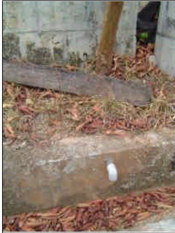
FOTO 58 MANTENIMIENTO DE CANALES PERIMETRALES
