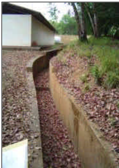
FOTO 35 CUNETAS PARA CONDUCCIÓN DE AGUAS LLUVIA
