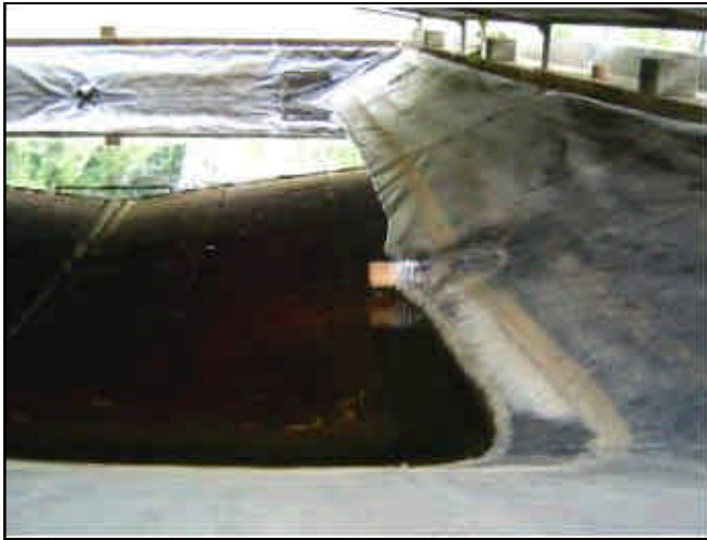
FOTO 12. PISCINA PARA LIXIVIADOS
