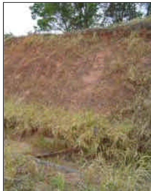
FOTO 27 TALUDES DEL RELLENO SANITARIO
