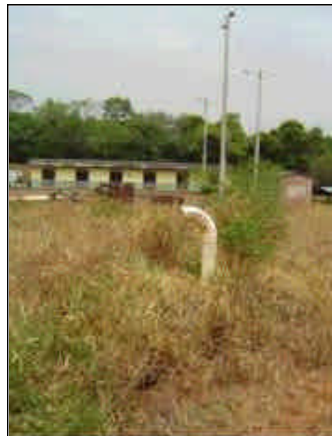
FOTO 17. CHIMENEA PARA GASES
