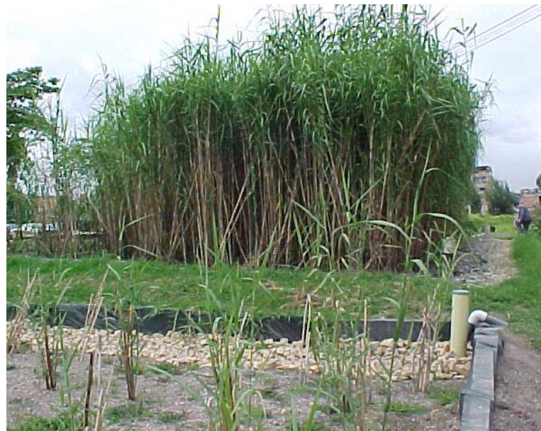
Figura 33. Planta de Tratamiento Horizontal para las Aguas de Lavado de Máquinas de Imprenta
