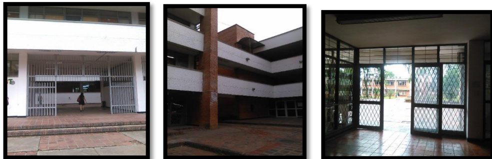
Figura 7. Entrada principal Laboratorios Livianos, pasillos comunicadores a Lab. Posgrados y Salida Sótano Laboratorios Livianos
