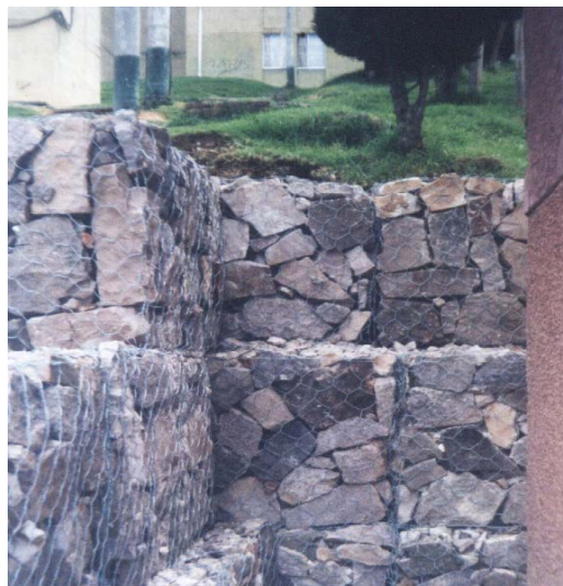
Figura 34. Gaviones para protección de la línea de Conducción 4" en la Urb. Santa Lucia
