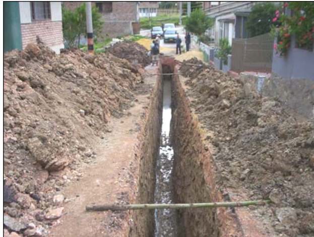
Figura 32. Excavación Mecánica Barrio Alcázares
