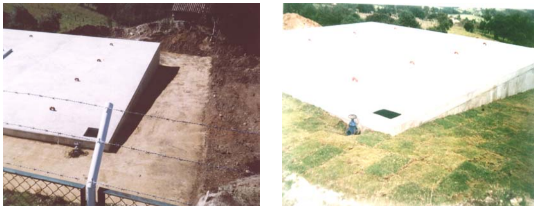
Figura 40. Relleno y Empradización
