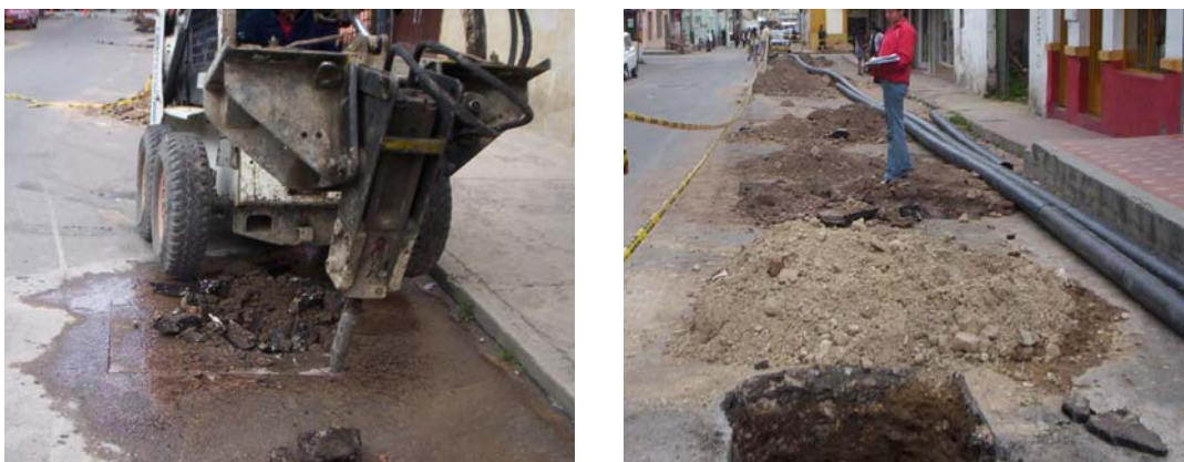
Figura 19. Corte de Pavimento y excavación para acometidas Domiciliarias
