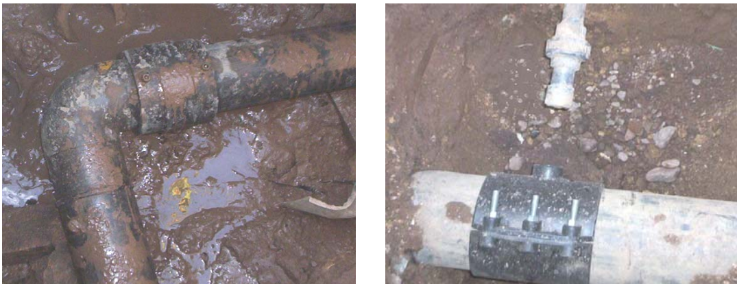
Figura 21. Ubicación De Accesorios En Polietileno
