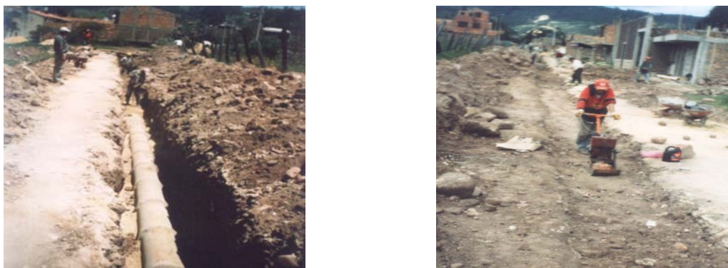
Figura 28. Construcción alcantarillado Barrio Manzanares
