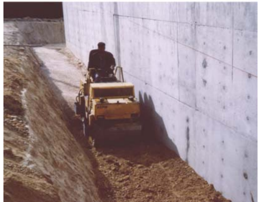
Figura 38. Compactación Material de Relleno
