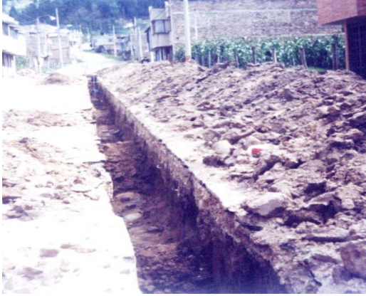
Figura 24. Instalación Acometidas Domiciliarias
