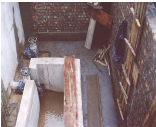
Figura 39. Construcción Caja de Válvulas
