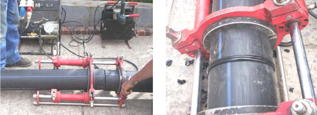
Figura 20. Unión de tubería en polietileno mediante termofusión.
