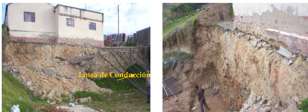
Figura 35. Muro de Contención para Protección Línea de Conducción 12".
