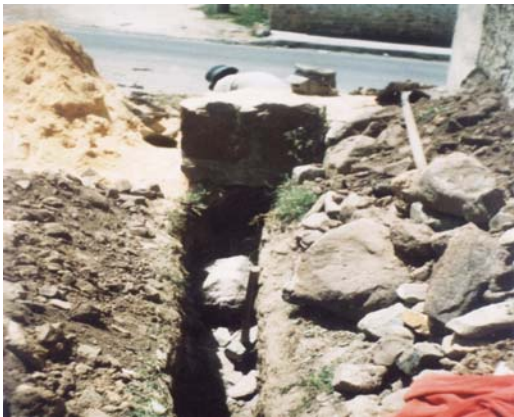
Figura 17. Excavación en Conglomerado Barrio Manzanares
