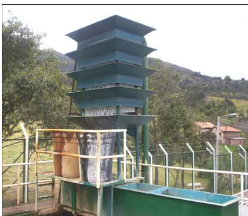
Figura 13. Torre de Aireación Planta Boyacogua
