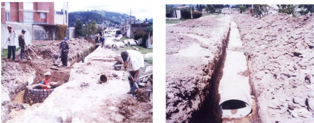
Figura 26. Construcción alcantarillado Barrio la Perla en tubería de 24"
