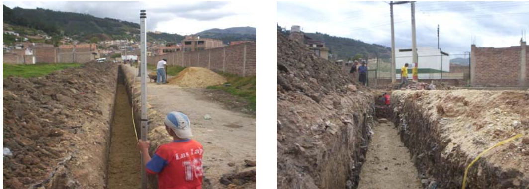
Figura 33. Construcción Alcantarillado Barrio Cándido Quintero
