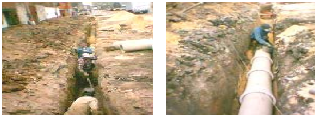
Figura 27. Construcción alcantarillado Barrio Fátima
