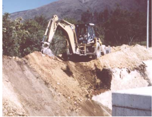
Figura 38. Compactación Material de Relleno
