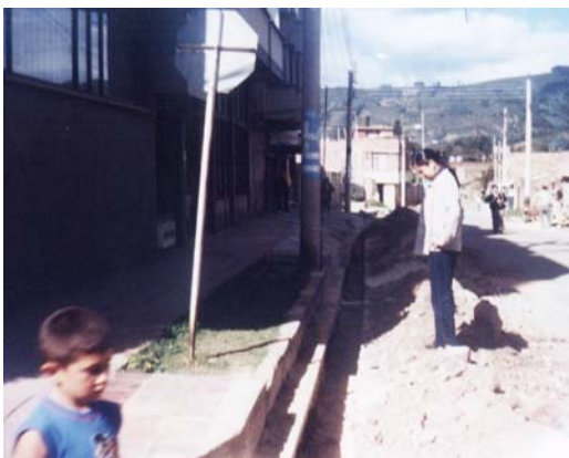
Figura 18. Construcción Acueducto Barrio Manzanares
