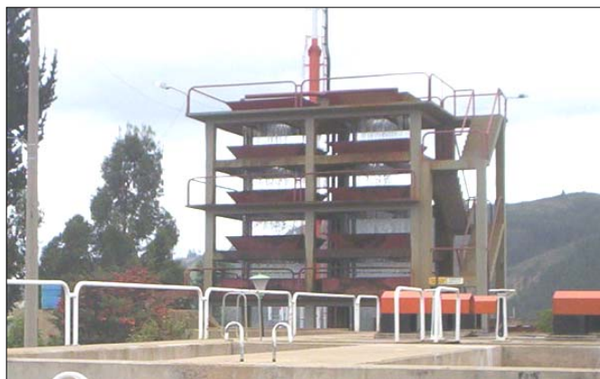
Figura 10. Torre de Aireación Planta la Milagrosa
