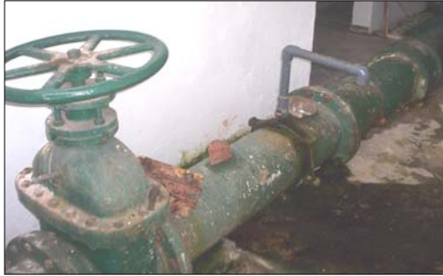
Figura 4. Llegada línea de Conducción
