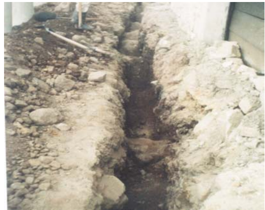
Figura 17. Excavación en Conglomerado Barrio Manzanares
