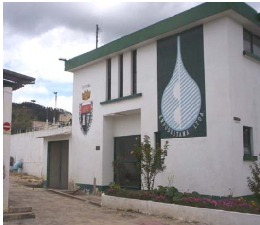
Figura 3. Vista General Planta El Surba
