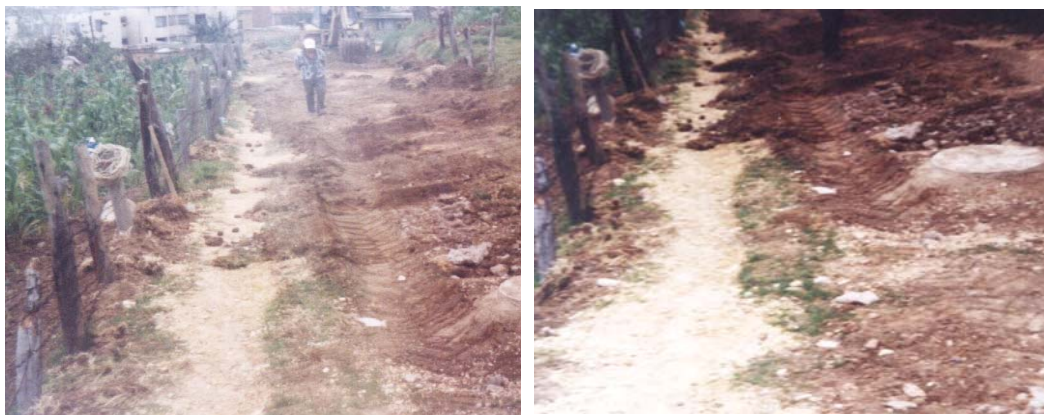
Figura 16. Ampliación del acueducto Barrio Divino Diño
