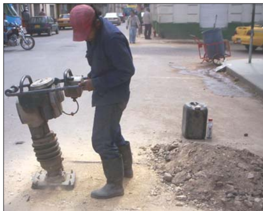
Figura 22. Relleno Y Compactación De Material Seleccionado
