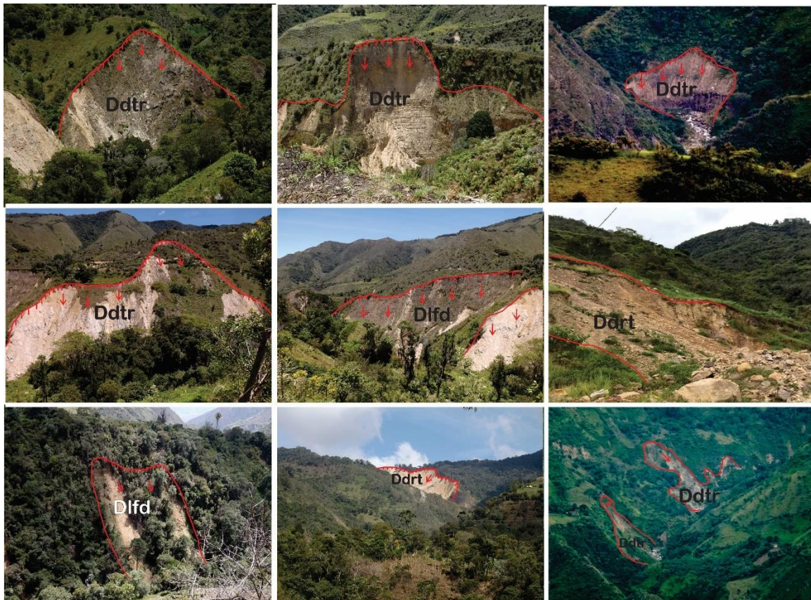
Figura 19. Movimientos en masa vistos en campo, dentro de los cuales se encuentran los deslizamientos de tipo Traslacional y Rotacional, y de Flujo de Detritos.
