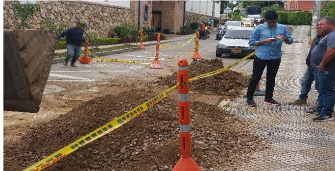
Figura 3. Visita de obra Lagos del Cacique.
