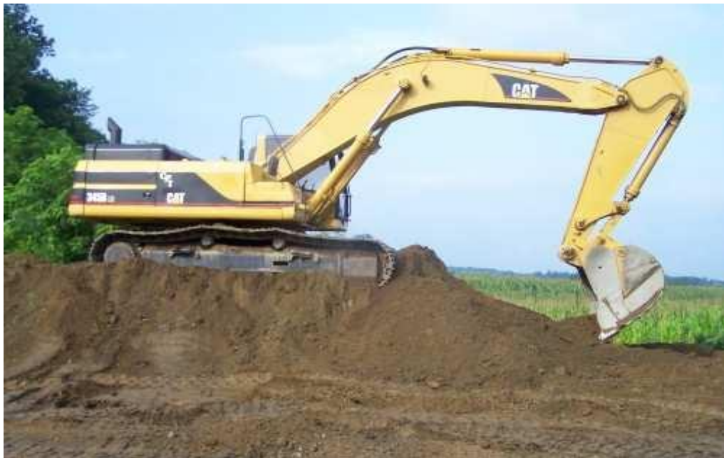
Figura 21. Excavadoras Caterpillar 345C
