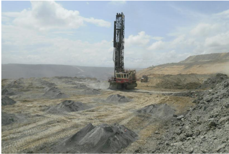
Figura 3. Área perforación para realizar una voladura
