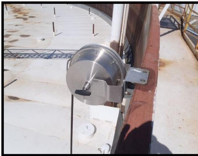
**Nota:** El RGA es usado en tanques de techo flotante como un sistema que conecta el techo flotante y el cuerpo del tanque. Tomado de SETI Equipos petroleros, n.d.
