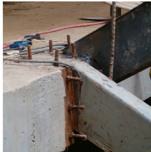
Figura 34. Instalación y funcionamiento de anclaje y platina para escalera.
