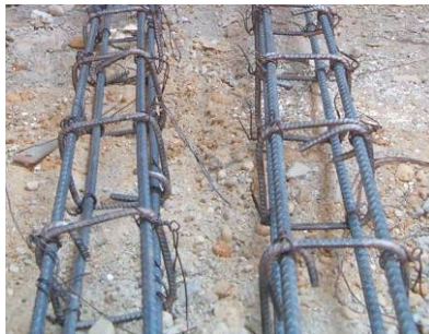
Figura 28. Muros confinados no estructurales.
