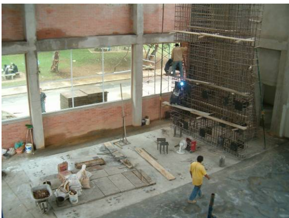
Figura 51. Instalación de platinas para muro de reacción.
