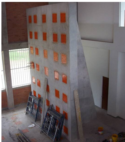
Figura 54. Estado final actual del muro de reacción y la losa de carga.
