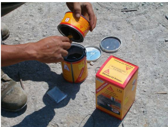
Figura 38. Aditivo para adherir concreto fresco a endurecido.
