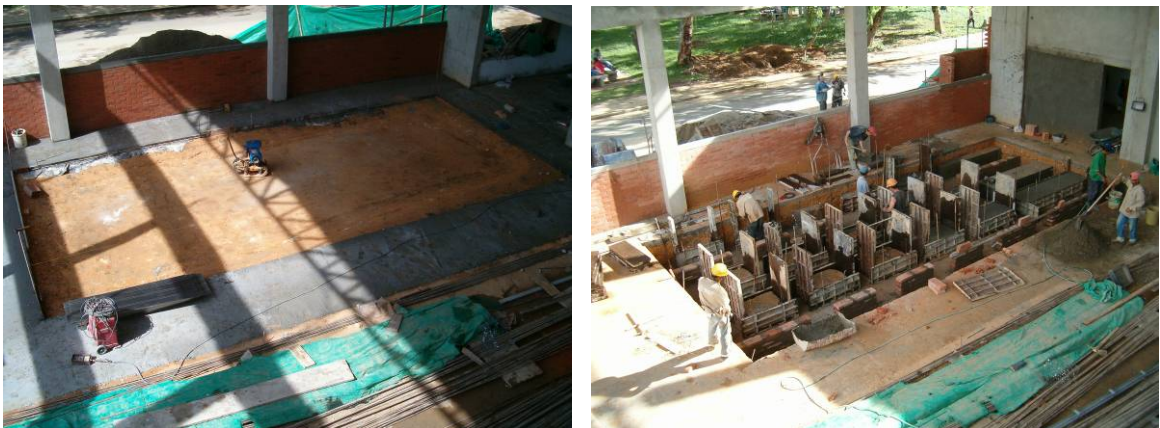
Figura 42. Ubicación y fundida de solado para la losa de carga.
