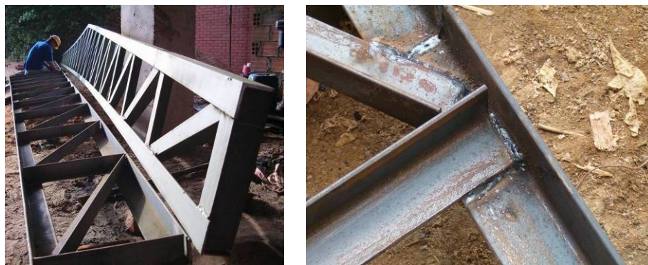
Figura 33. Cerchas metálicas para cubierta del laboratorio de estructuras.
