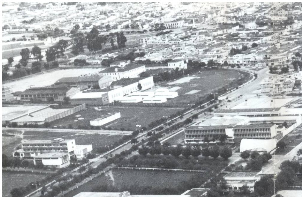
Figura 69. Edificio de Administración (izquierda), Mecánica y su auditorio (derecha).
