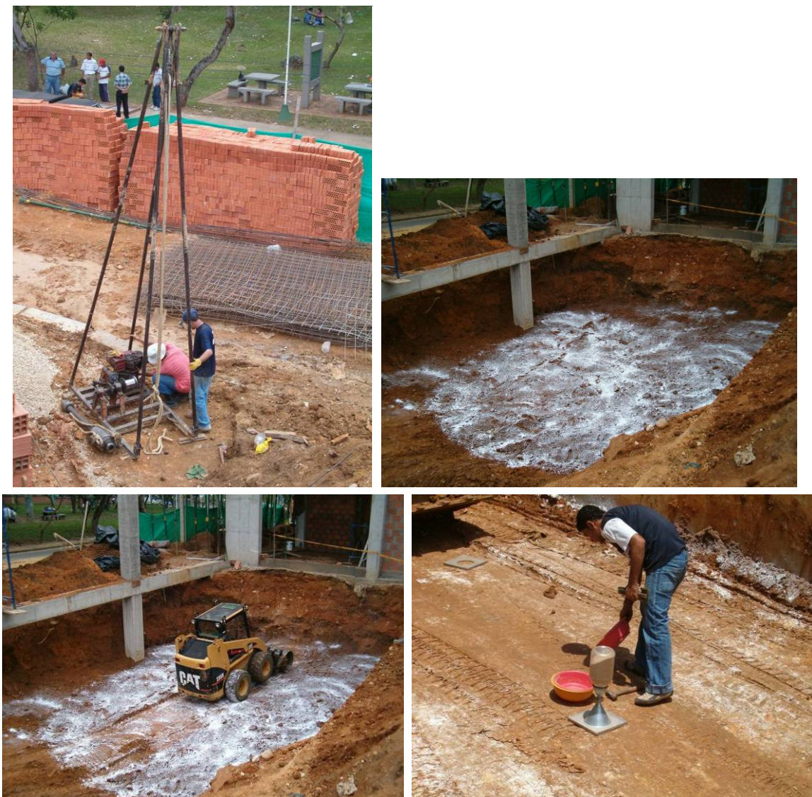
Figura 22. Ensayo SPT, Compactación con cal y ensayo cono de arena.
