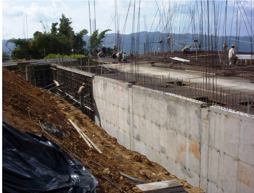
Figura 7. Desencofrado y formateado de muro de contención de tierras.
