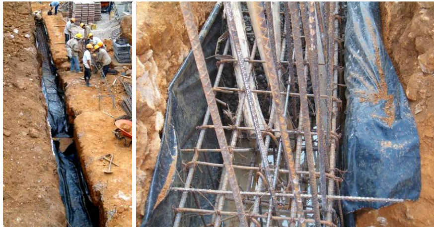
Figura 26. Cimentación para muro de contención de tierras.
