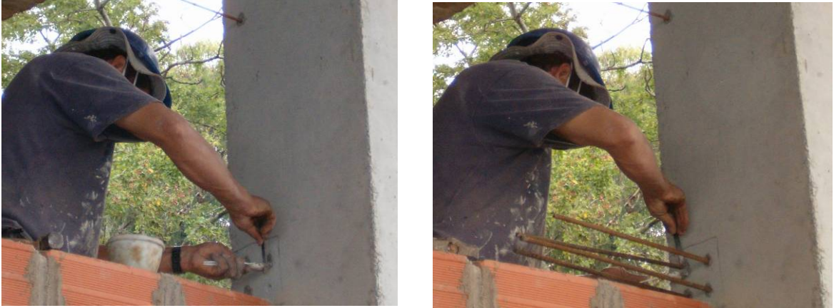
Figura 39. Producto fijador de anclajes de acero en concretos.
