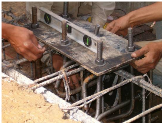
Figura 34. Instalación y funcionamiento de anclaje y platina para escalera.
