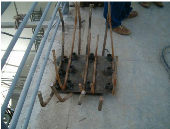
Figura 48. Soldado de platinas para losa y pruebas de tensión para pernos de anclaje.
