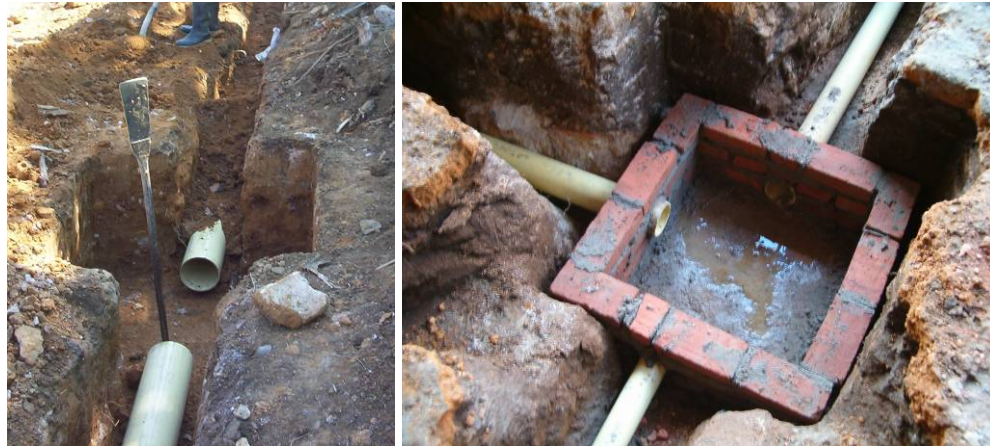
Figura 31. Cajas de inspección en la fachada y en sótano, en proceso.
