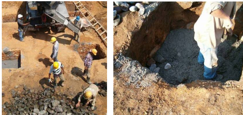
Figura 25. Producción de concreto ciclópeo bajo el acceso principal.
