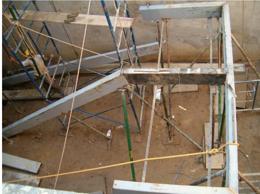
Figura 11. Etapas iniciales de construcción de la escalera metálica autoportante.
