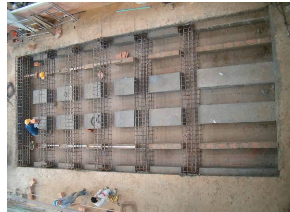
Figura 43. Instalación de hierro previamente figurado para vigas norte –sur.
