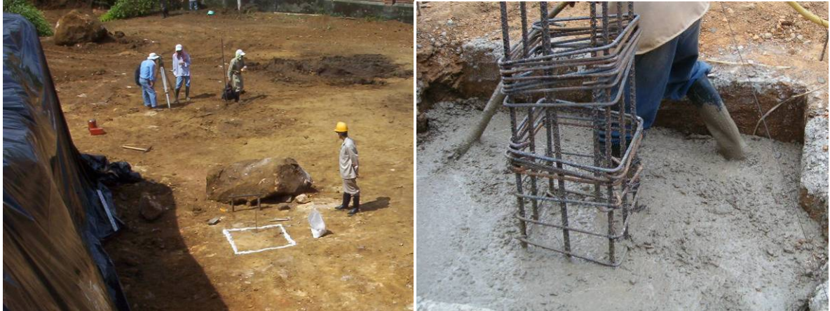
Figura 6. Localización, excavación y conformación de zapatas aisladas.
