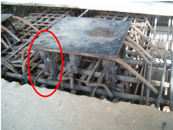
Figura 49. Instalación de platinas en losa de carga.
