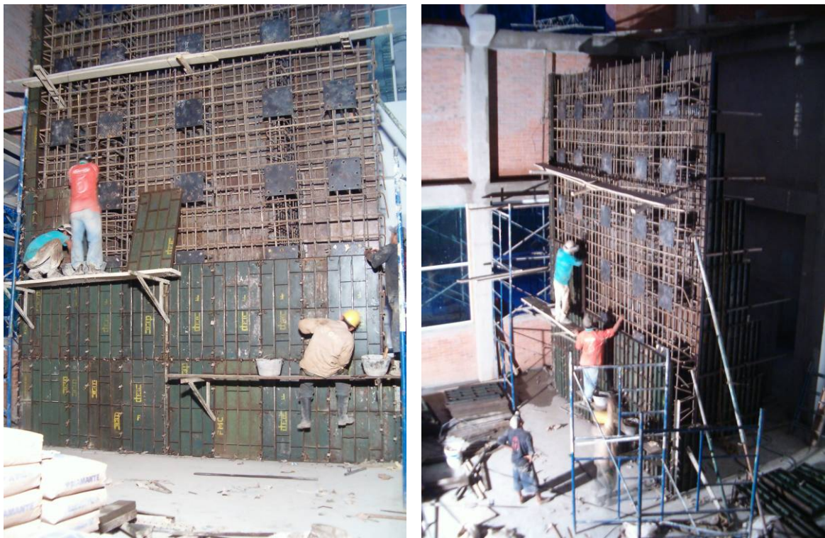
Figura 52. Formateado del muro de reacción.
