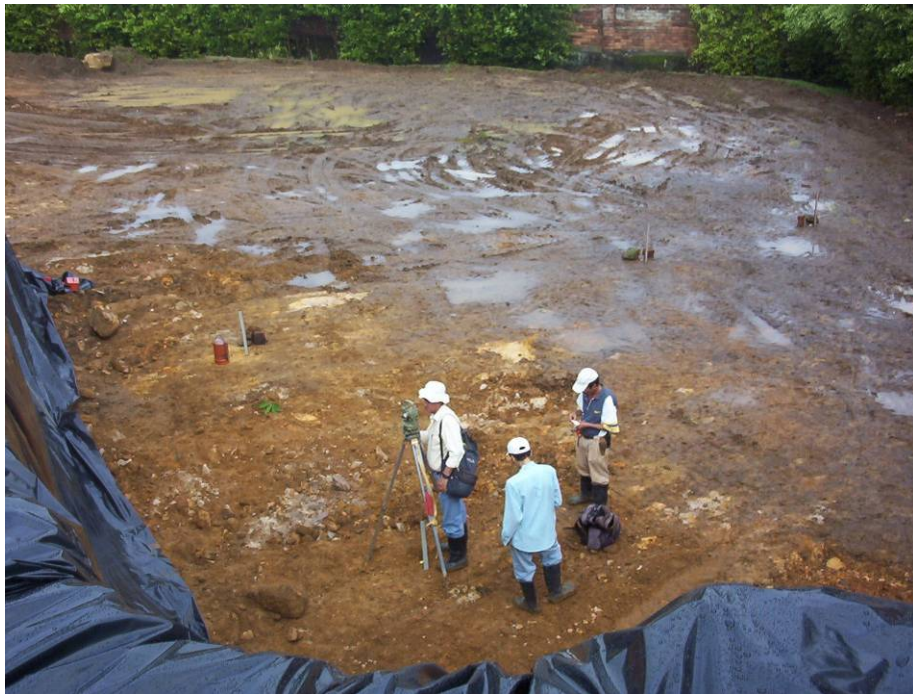
Figura 5. Excavación para conformación del sub sótano.
