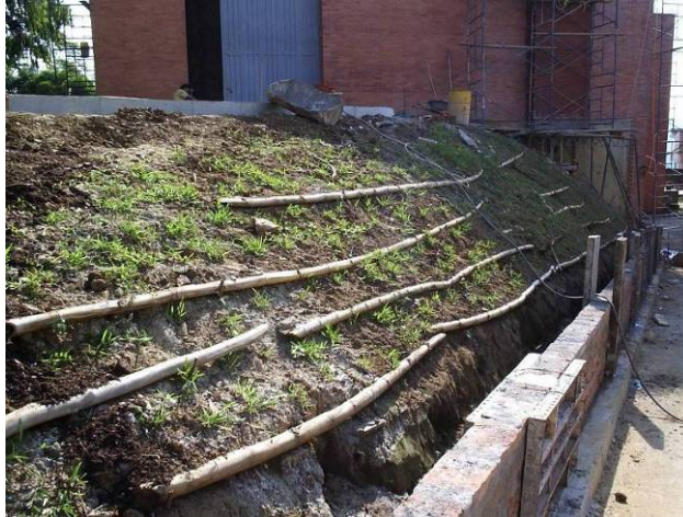
Figura 24. Estabilización de talud con empradización, largueros de guadua y muro.
