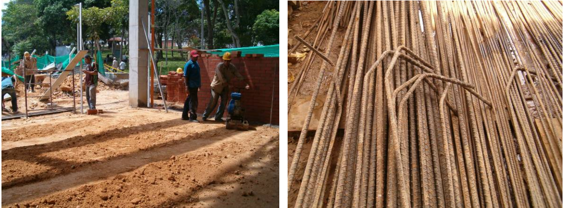
Figura 41. Almacenamiento de acero y compactación red eléctrica e hidrosanitaria.
