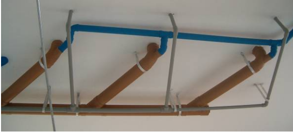
Figura 32. Redes hidrosanitarias internas bajo placa (baño mujeres)
