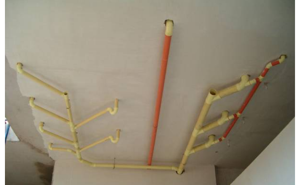
Figura 32. Redes hidrosanitarias internas bajo placa (baño mujeres)
