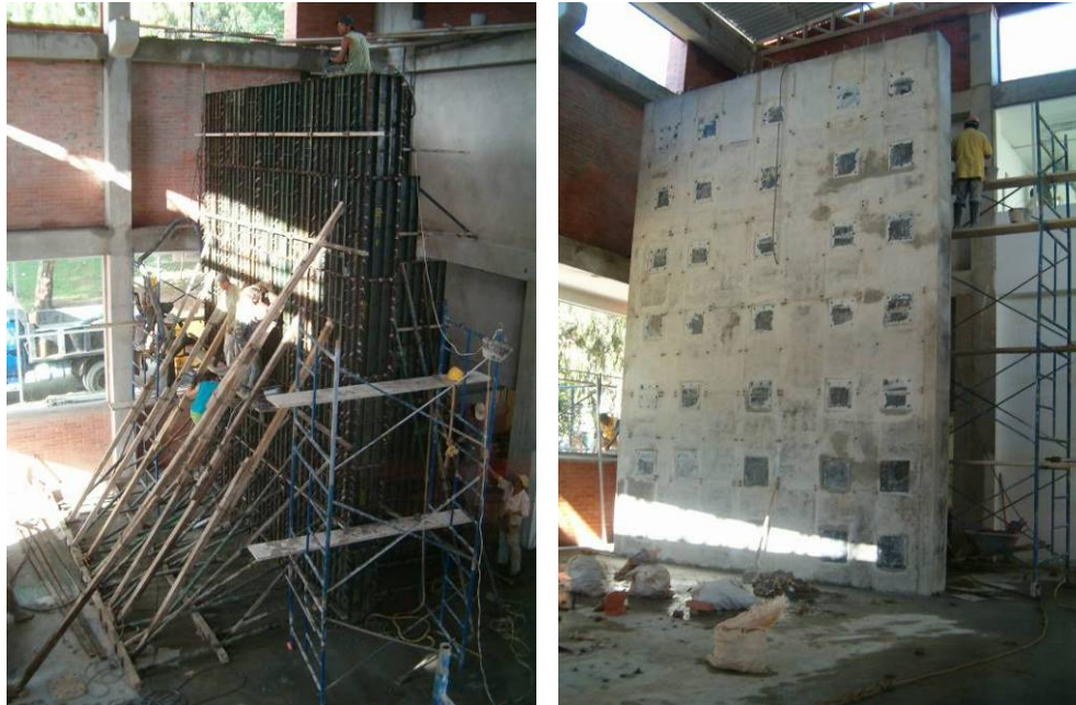
Figura 53. Formaleteado y fundida del muro de reacción.
