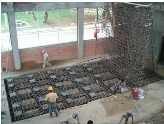
Figura 50. Trabajos de fundida en concreto 4000psi para losa de carga.
