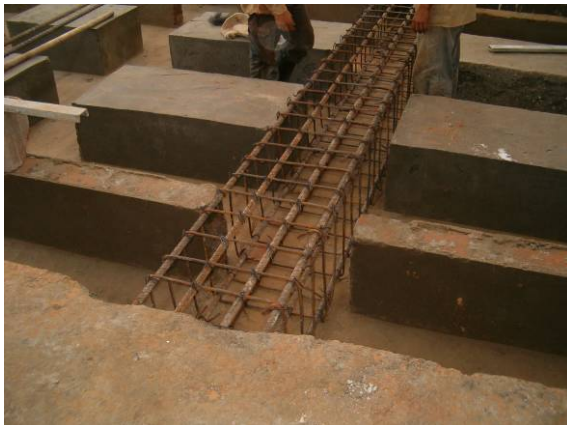
Figura 43. Instalación de hierro previamente figurado para vigas norte –sur.
