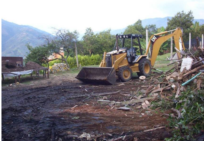
Figura 4. Iniciación de trabajos de obra civil.
