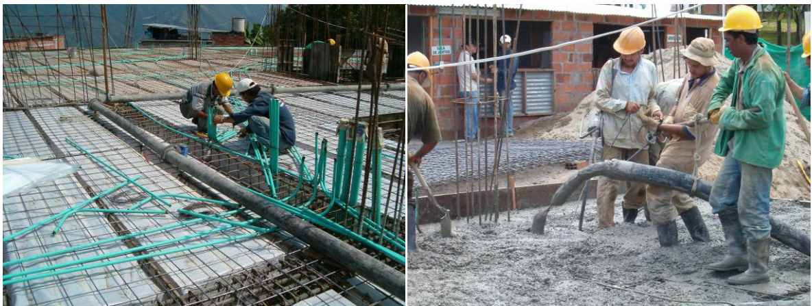
Figura 8. Instalación de ductos eléctricos y fundida de placa N+0.00m
