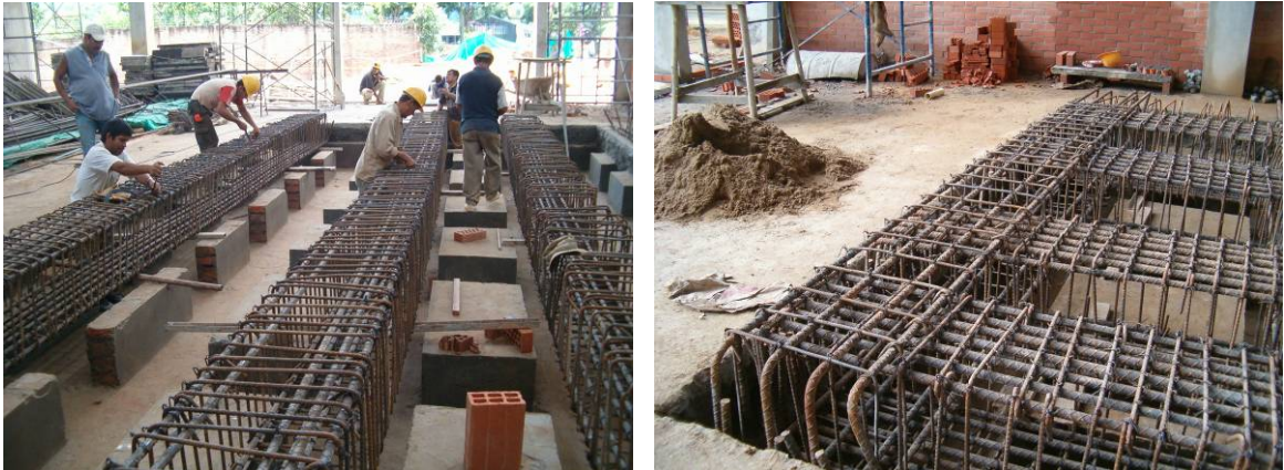
Figura 44. Armado del acero para vigas este – oeste y norte – sur.
