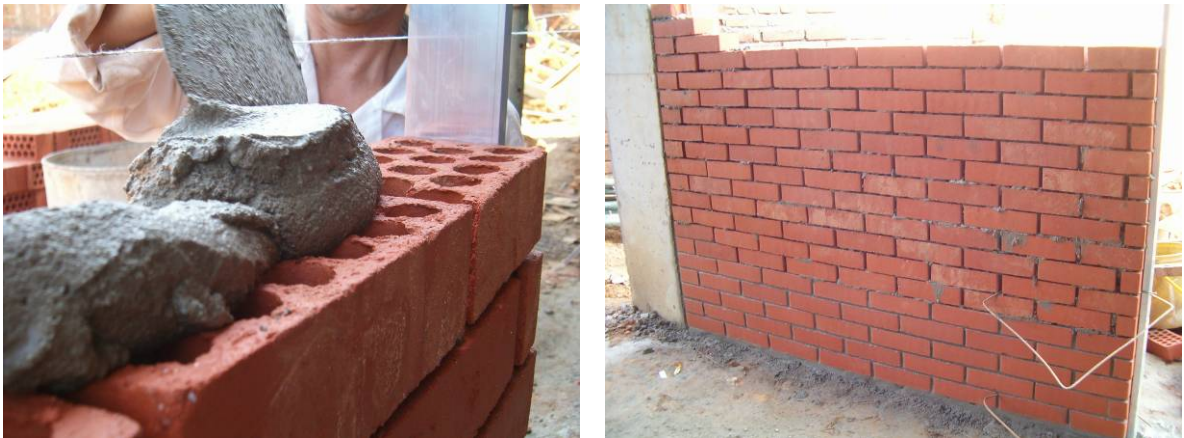
Figura 35. Muro en ladrillo tipo hollman a la vista primeros de los 1650m 2 en total.
