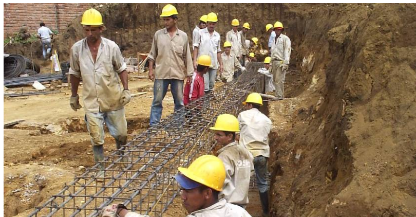
Figura 36. Uso generalizado del casco protector en actividades de obra.
