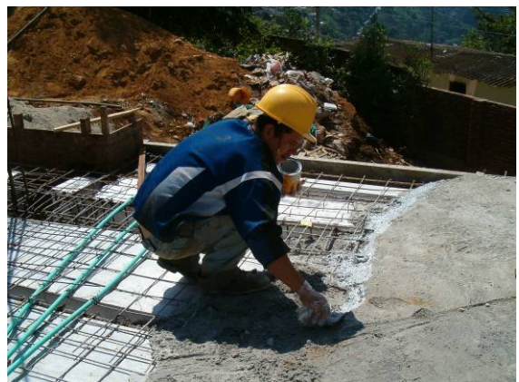
Figura 38. Aditivo para adherir concreto fresco a endurecido.
