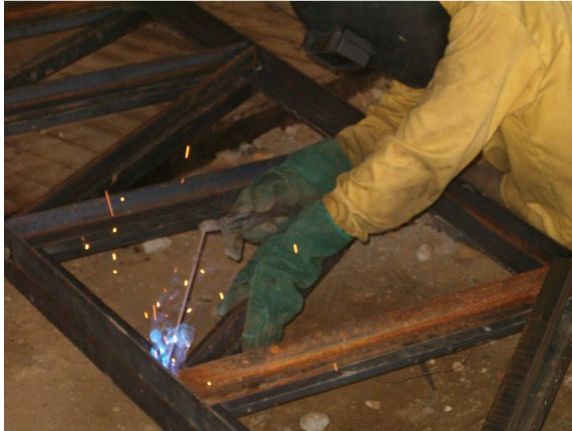
Figura 10. Ubicación y soldada de elementos en acero de las cerchas.
