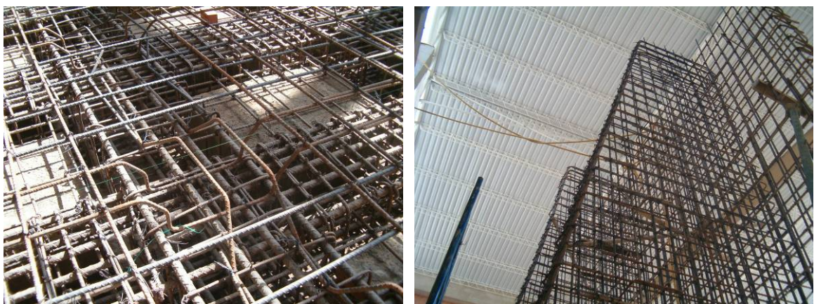
Figura 47. Instalación de acero bajo platinas y armado de contrafuertes.
