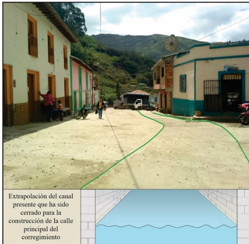
Figura 2. Representación del cauce de la Quebrada Miracielo debajo de la calle principal del corregimiento de Bábega. La línea verde corresponde a los muros del canal en superficie.
