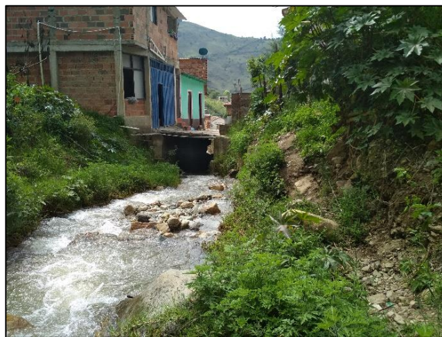
Figura 28. Canalización de la quebrada en la parte inicial de corregimiento.
