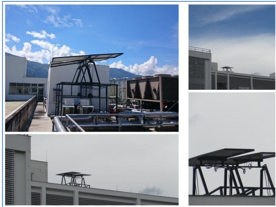
Figura 6. Instalación de paneles fotovoltaicos en el Parque Tecnológico Guatiguará
