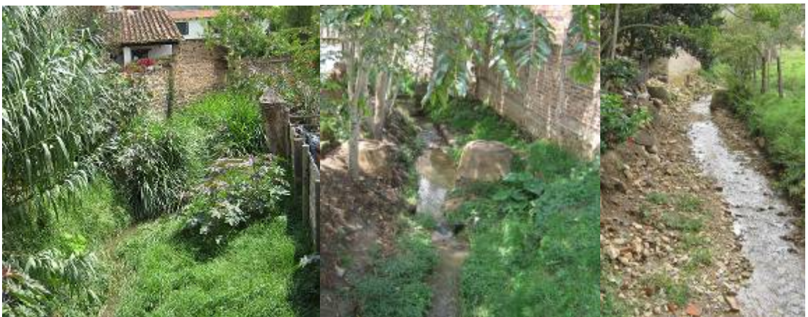
Figura 36. Quebrada San Francisco. Riberas intervenidas.
