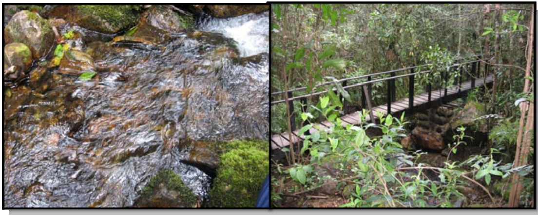
Figura 14. Carrizal medio. Aguas claras. Puente sobre la quebrada Carrizal
