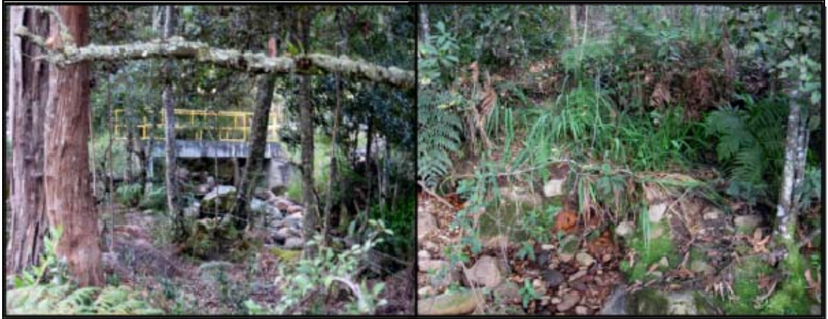
Figura 31. Punto Ortigal Bajo. Puente Sobre la Quebrada La Colorada
