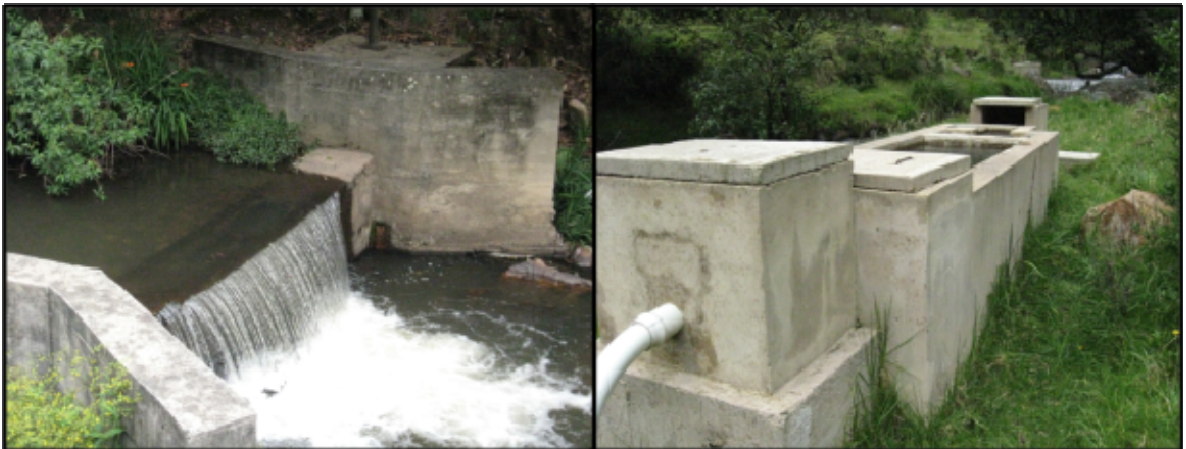
Figura 34. Captación de agua sobre el río Cane para su posterior potabilización
