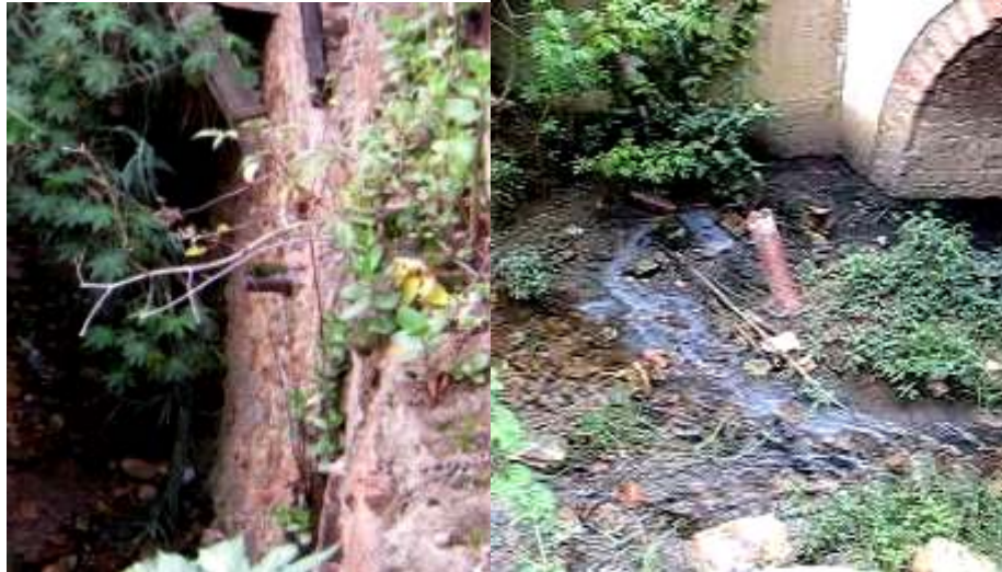
Figura 37. Vertimientos puntuales sobre la quebrada San Agustín (Izq.) y sobre la quebrada San Francisco (Der.)
