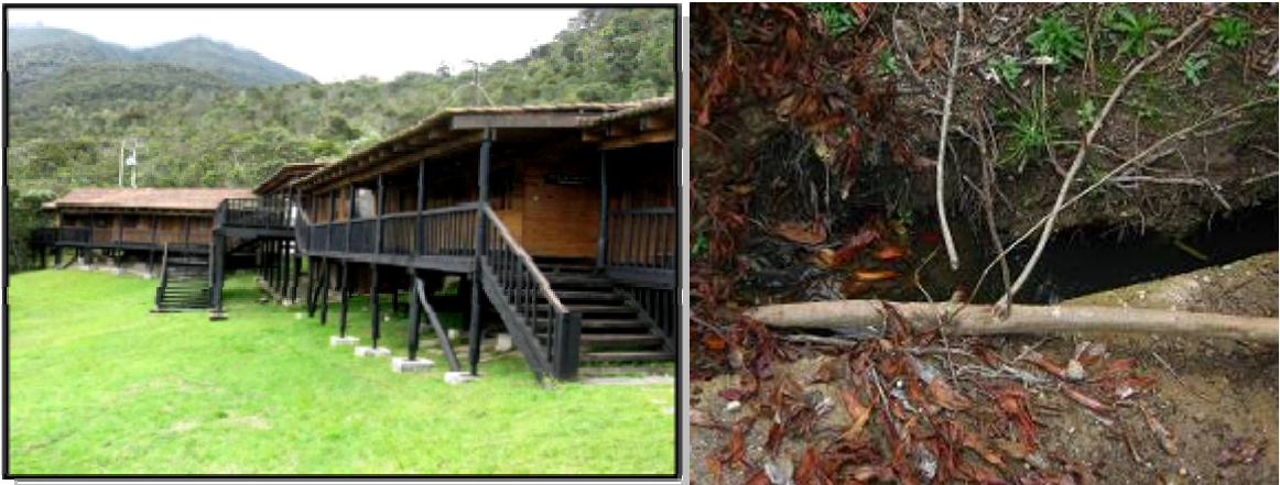
Figura 15. (Izq.) Centro de visitantes. (Der.) Pozo Séptico sobresaturado
