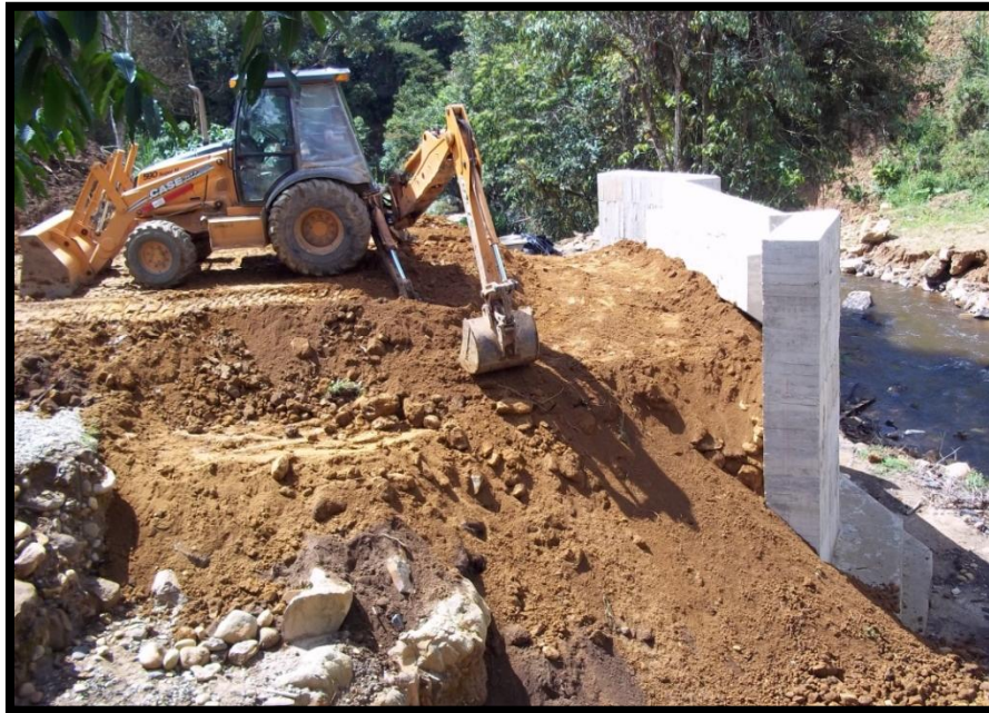
Fotografía 38. Avanza conformación de rellenos
