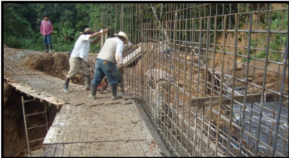
Fotografía 25. Inicia fundida de muros elevación margen izquierda
