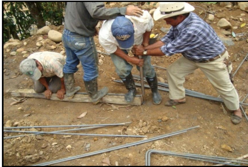
Fotografía 17. Figurado en campo de varillas 5/8” para anclajes
