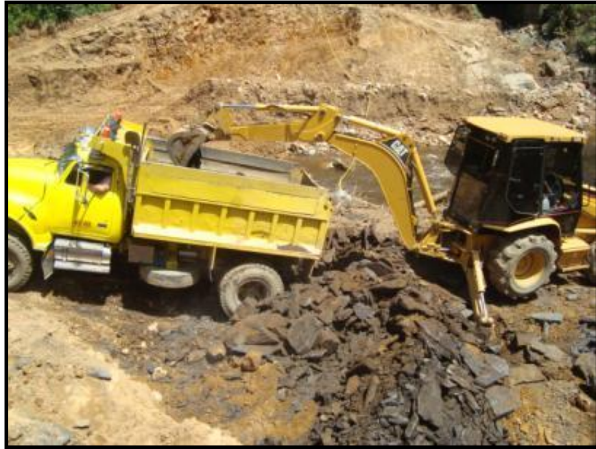
Fotografía 13. Retiro de material producto de la excavación
