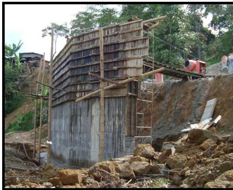
Fotografía 31. Aletas y vástago se observan en ejecución
