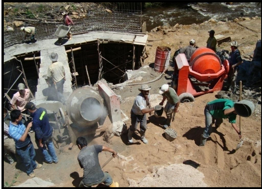
Fotografía 30. Concreto preparado en obra y transporte al sitio de vaciado
