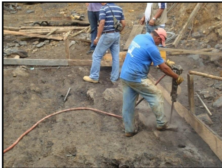
Fotografía 18. Perforaciones en roca de 3/4” de diámetro y 35 cm de profundidad
