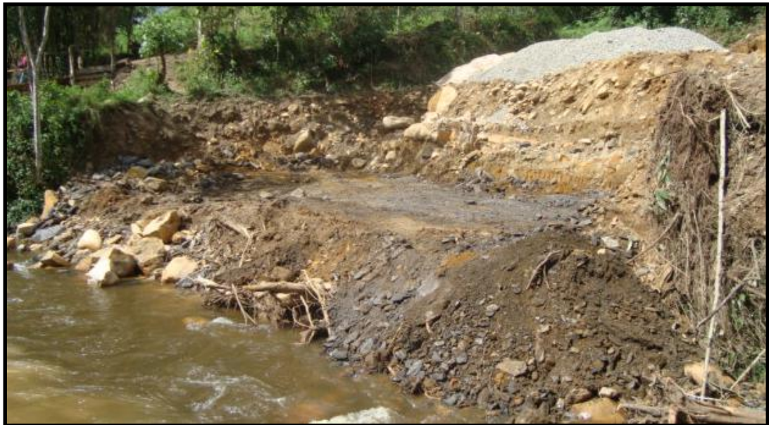
Fotografía 14. Finaliza excavación en roca margen izquierda
