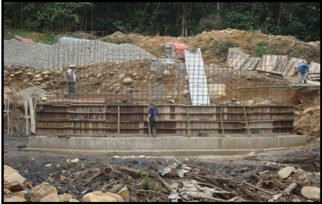
Fotografía 24. Formaleteado para fundir primera sección del muro de elevación
