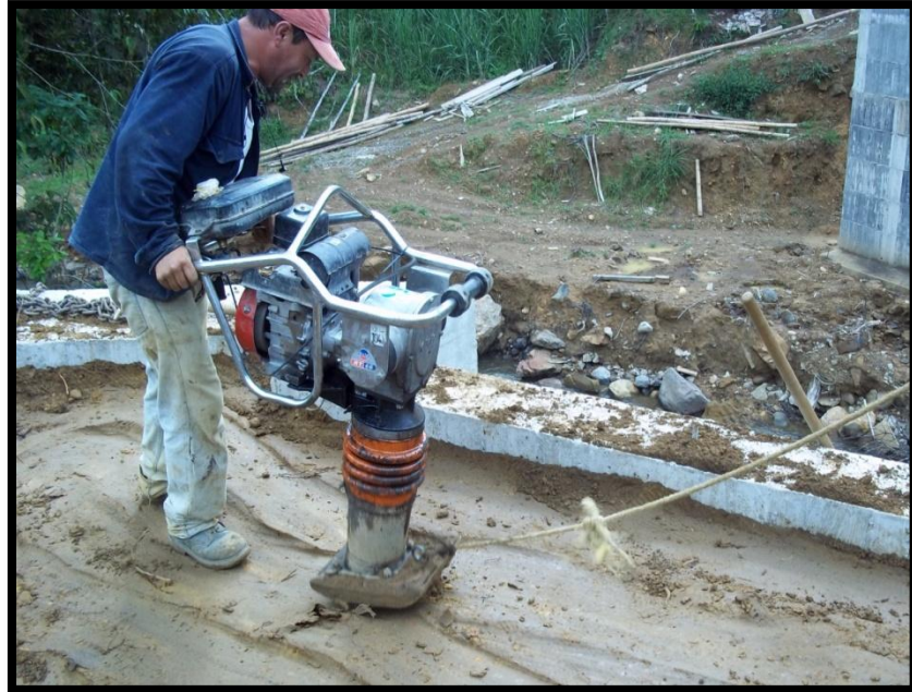
Fotografía 39. Una a una se compacta cada capa.
