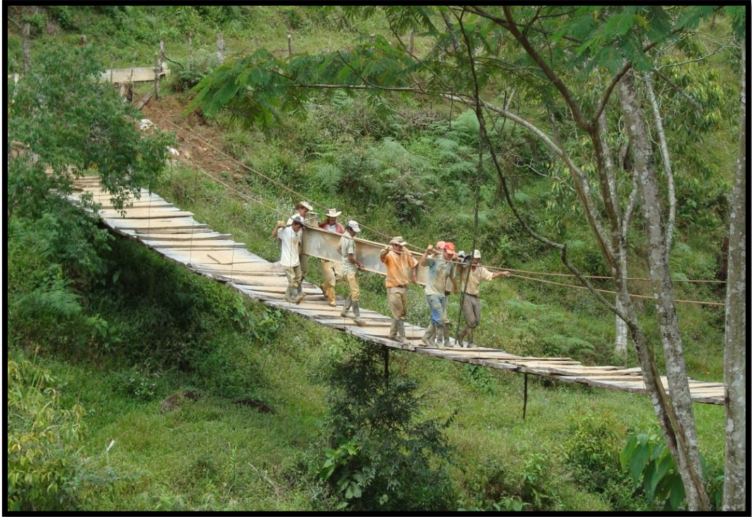
Fotografía 40. Traslado de elementos del puente tipo Callender
