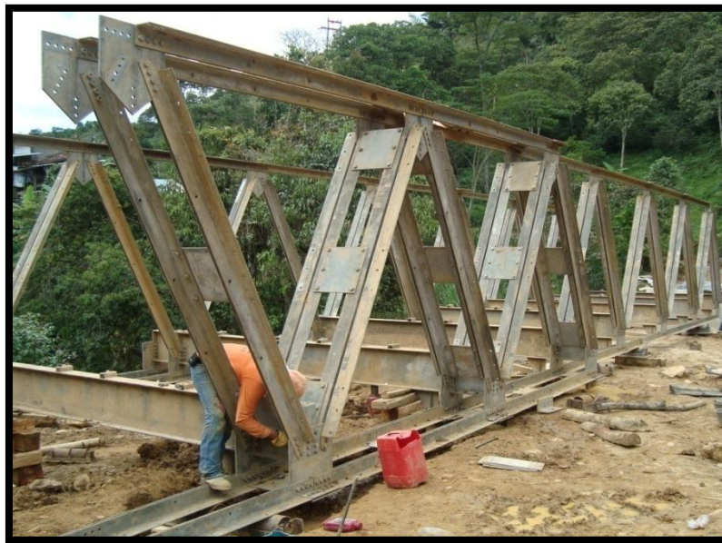
Fotografía 41. Unión de elementos y perneado de los mismos
