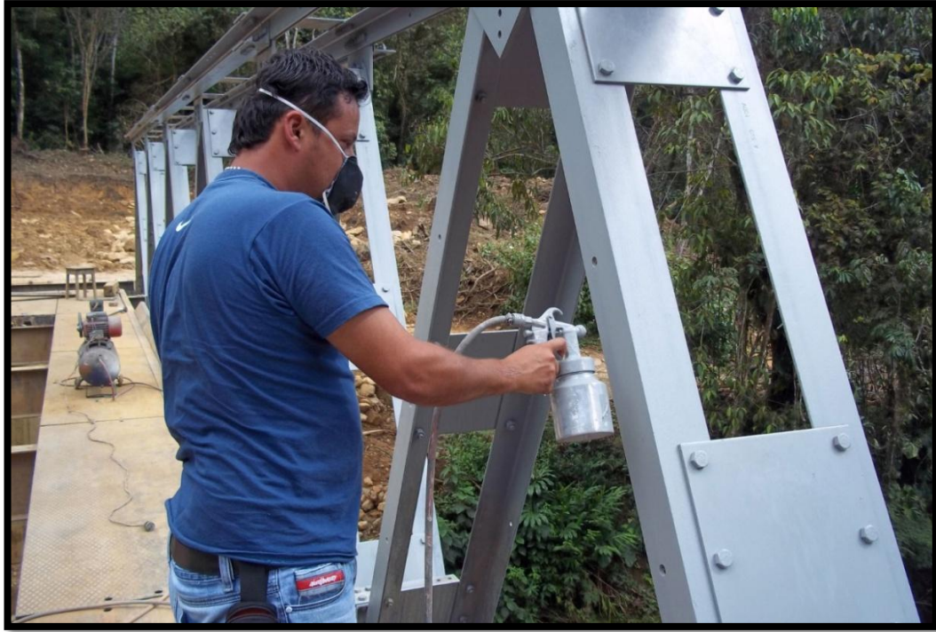
Fotografía 46. Aplicación de recubrimiento anticorrosivo
