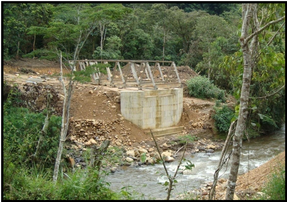
Fotografía 43. Secciones armadas listas para el lanzamiento
