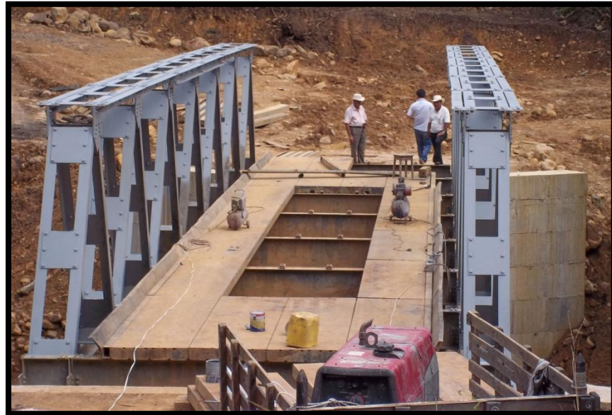
Fotografía 47. Avanza la pintura e instalación de tableros.
