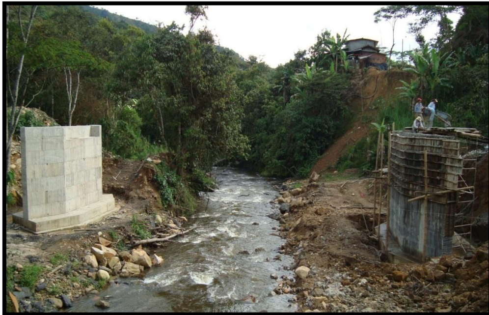
Fotografía 33. Panorámica de estribos terminados
