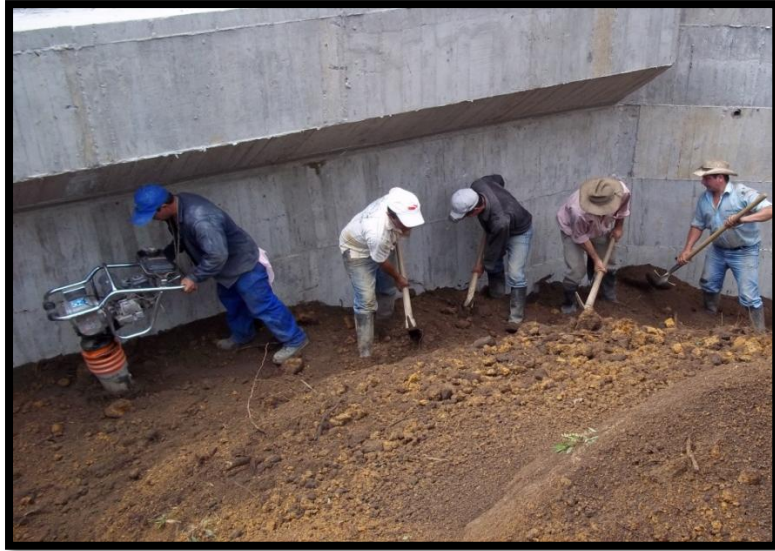
Fotografía 37. Extensión y compactación del material de relleno
