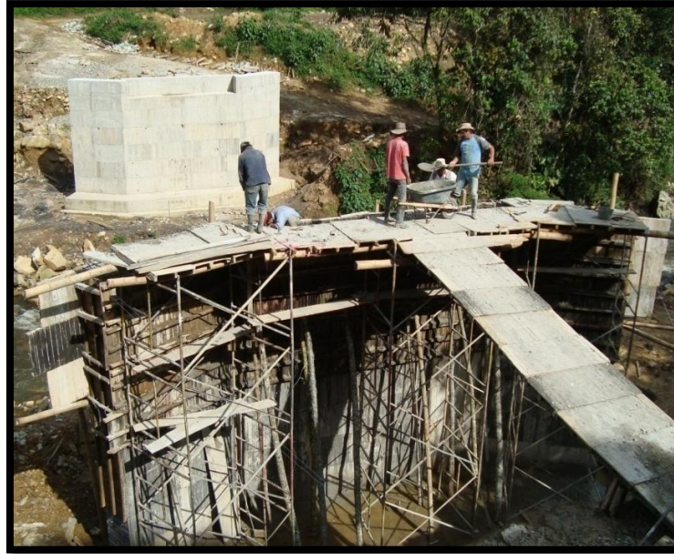
Fotografía 32. Avanza fundida de muros de elevación
