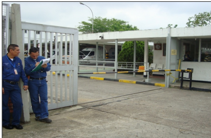
Ilustración 24. Puerta Principal de Acceso Urgencias
