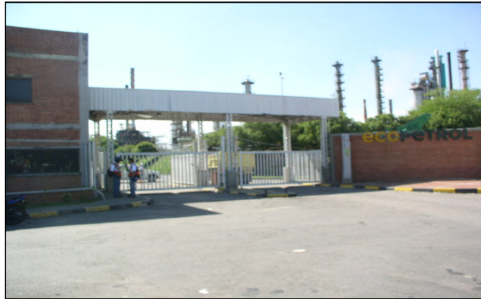
Ilustración 20. Puertas de ingreso y salida vehicular
