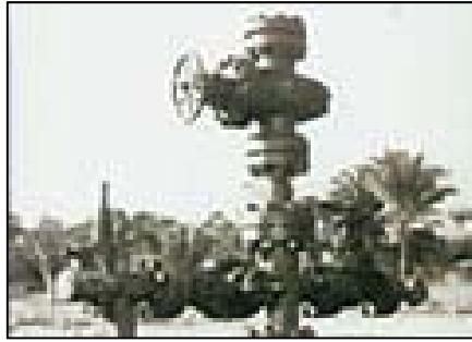
Ilustración 2. Estación de bombeo Caño Limón
