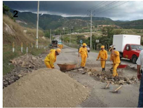
FOT. 2- REMOCION DE MATERIAL CONTAMINADO-
