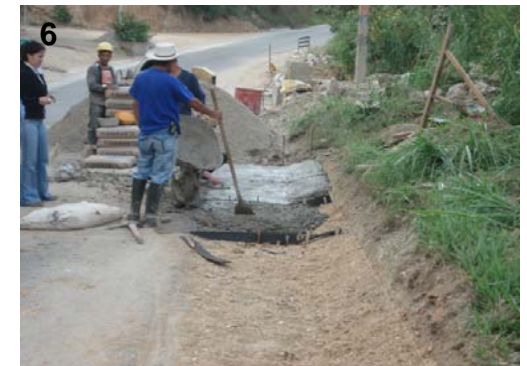
FOT.6- OBRAS COMPLEMENTARIAS DE DRENAJE-
