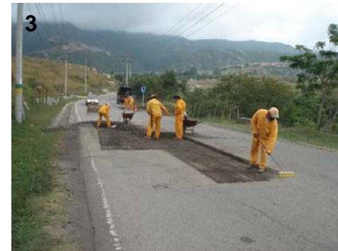
FOT. 3- PREPARACION DEL TERRENO-
