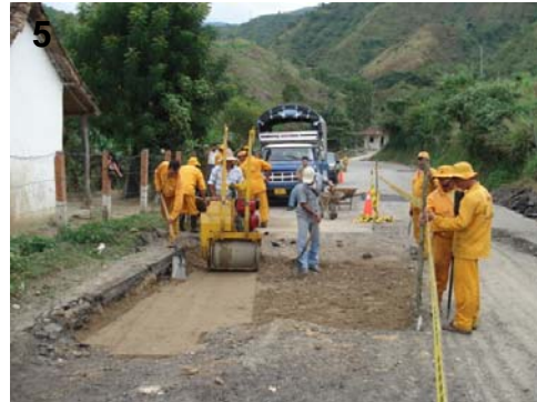
FOT.5- TRABAJOS DE COMPACTACION-
