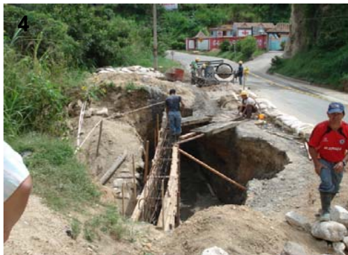
FOT. 4- INSPECCION DE CIMENTACION Y COLOCACION DE REFUERZO.-
