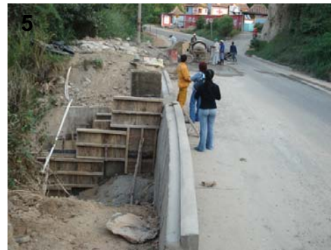
FOT.5- OBRA PRINCIPAL TERMINADA-
