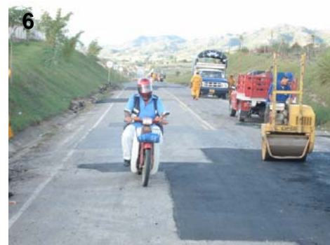
FOT.6- ESTADO FINAL DE LA BANCA-
