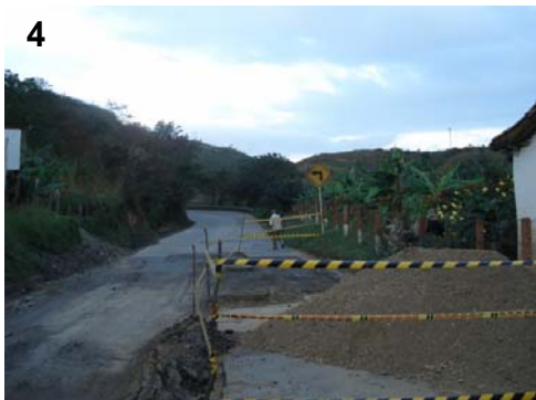
FOT. 4- SUMINISTRO Y REPOSICION DE BASE.-
