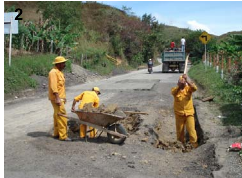
FOT. 2- REMOCION DE MATERIAL CONTAMINADO-
