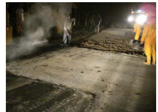
FOT.6- COLOCACION DE LA MEZCLA ASFALTICA-
