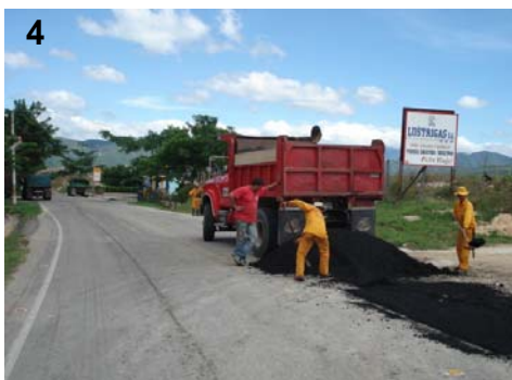
FOT. 4- INSPECCION A LA CALIDAD DEL SUMINISTRO Y SU EXTENDIDA-
