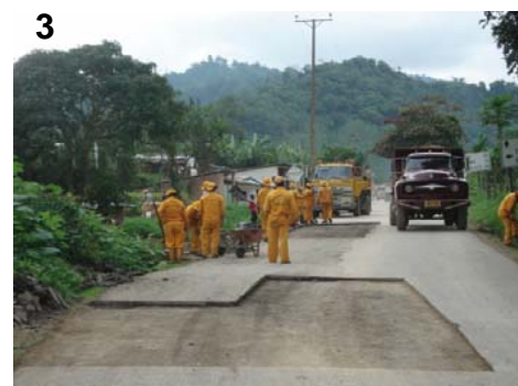
FOT. 3- PREPARACION DEL TERRENO-
