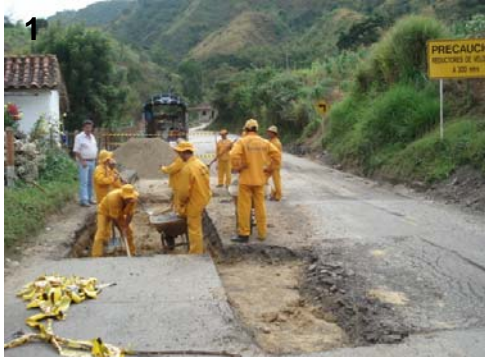
FOT. 1- TRABAJOS DE EXCAVACION-
