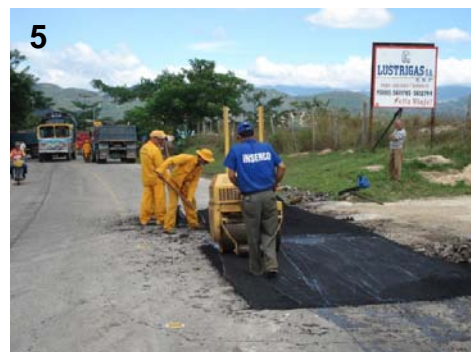
FOT.5- TRABAJOS DE COMPACTACION-
