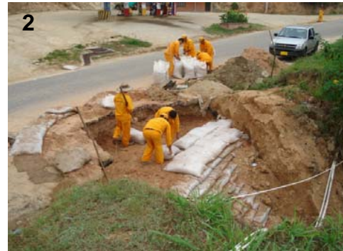
FOT. 2- TRABAJOS PROVISIONALES CON MICROS-
