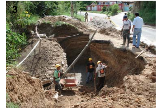
FOT. 3- INICIO AL CONTRATO DE OBRA No2064-2006.-
