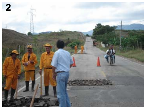
FOT. 2- TRABAJOS PDE EXCAVACION CON MICROS-
