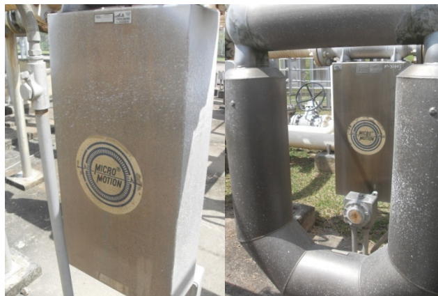
Figura 9. MEDIDOR TIPO CORIOLIS
