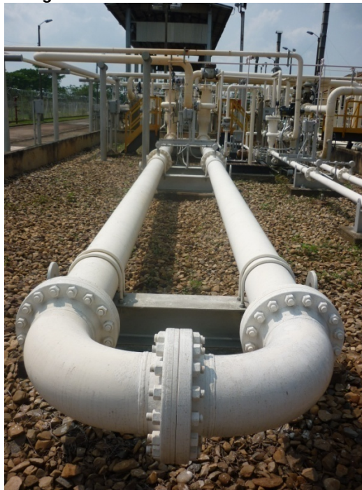
Figura 20. PROBADOR BIDIRECCIONAL
