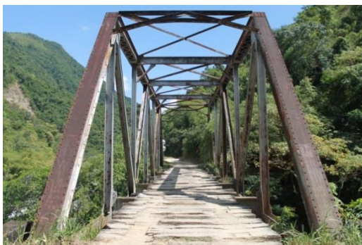
Figura 6. Puente La Honda. Vista frontal Armadura Superior.
