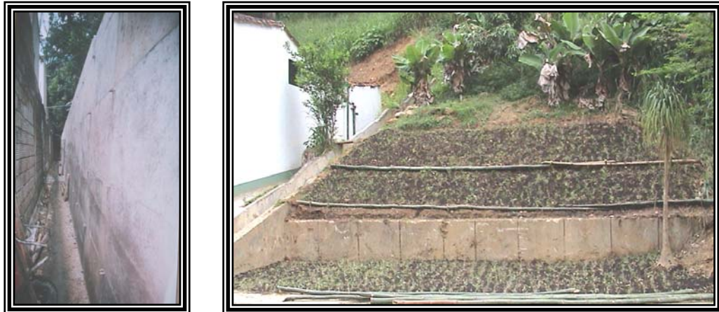
Figura 10. Detalles de Muro ciclópeo y empradización del talud.
