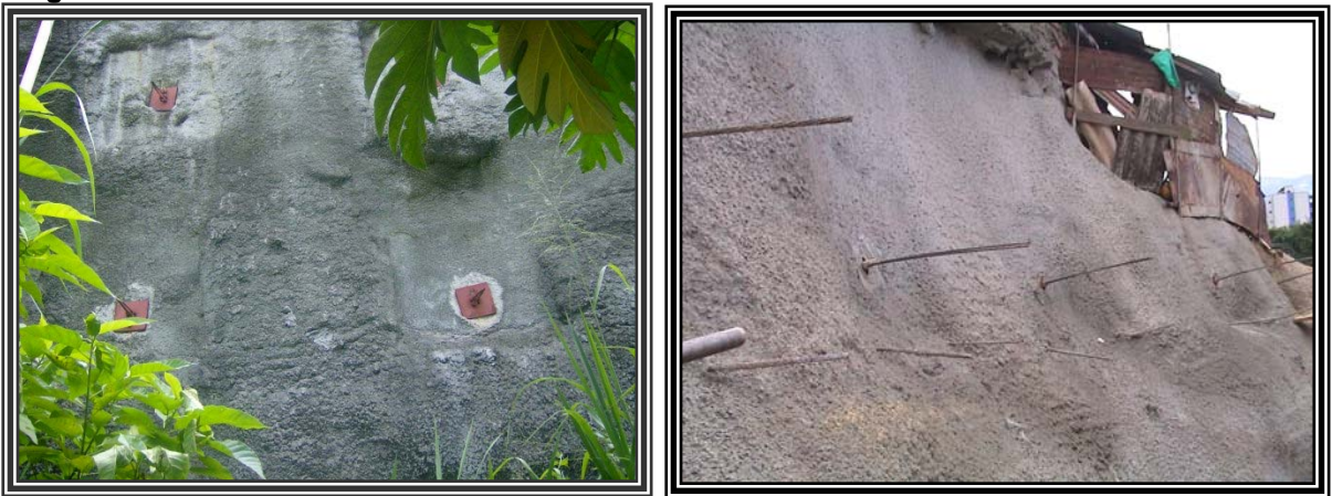
Figura 13. Detalle de Pantallas Ancladas
