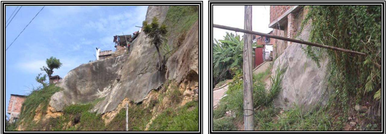
Figura 12. Detalle de concreto Lanzado
