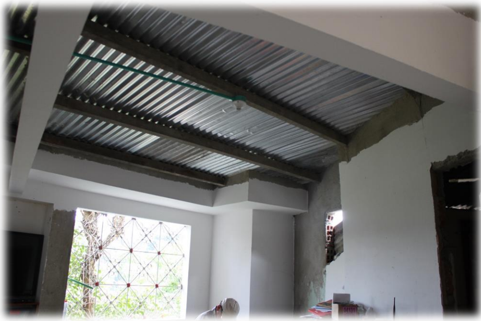
Figura 14. Techos en lámina de zinc
