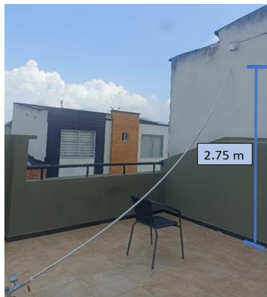
Figura 17. Montaje tubería de descarga
