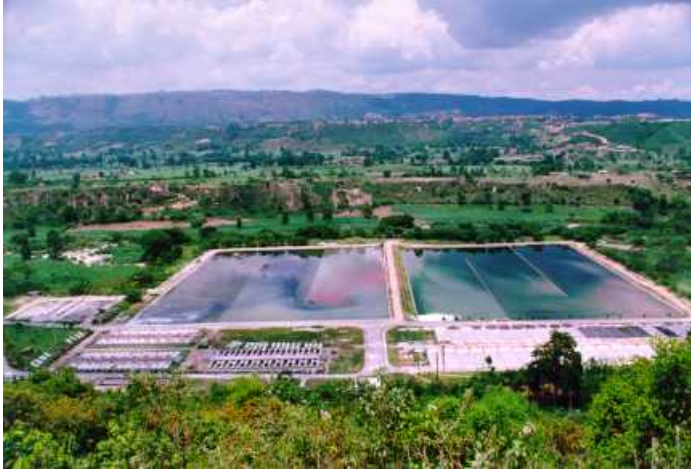
Foto 1. Vista Aérea PTAR Río Frío
