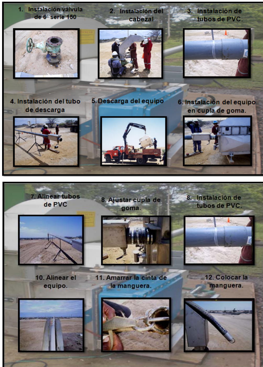
Figura 64. Proceso de Instalación.
