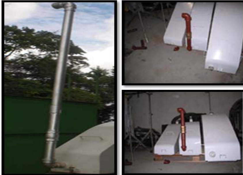
Figura 43. Venteo Anti Gas Explosivo.
