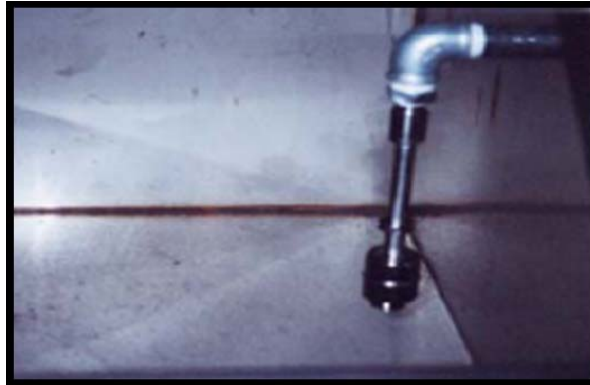
Figura 42. Sensor de Nivel de Tanque de Recolección.
