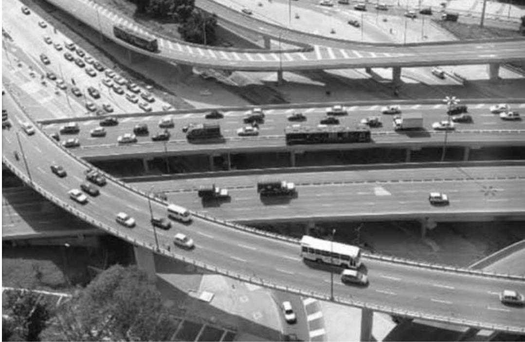
Figura 9. Puente tercer nivel calle 92 Bogotá
