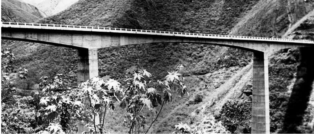
Figura 6. Puente sobre el río Juanambú (Putumayo)
