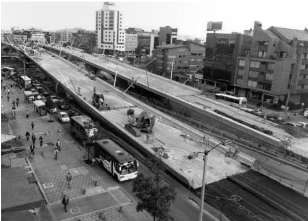
Figura 12. Puente calle 100 Bogotá
