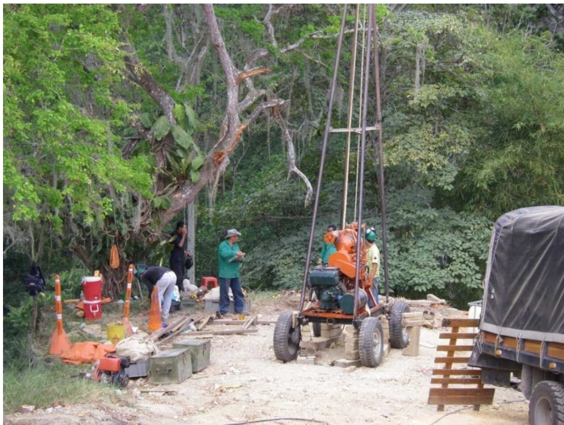
Figura 4-23 Sondeo en el costado nororiental del lote en mayo de 2010, a profundidad de 35.0 metros.
