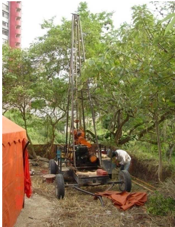
Figura 4-22 Sondeo Sept. 2003. En este sondeo hasta los 15.0 metros aparecieron suelos aluviales del miembro Limos rojos
