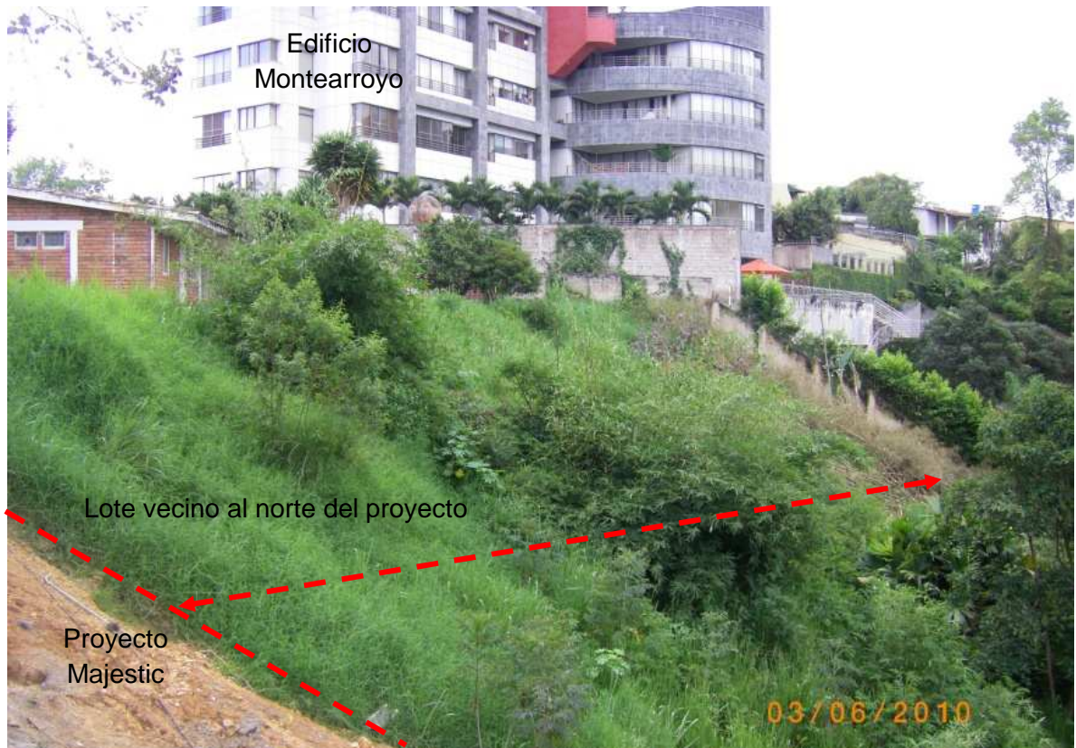
Figura 4-5 Ladera al costado norte del proyecto, luego el edificio “Montearroyo”
