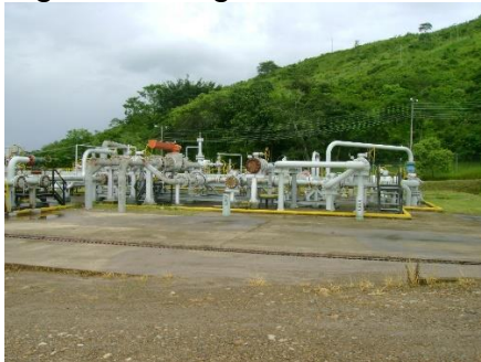
Figura 13 Llegada de Pozos
