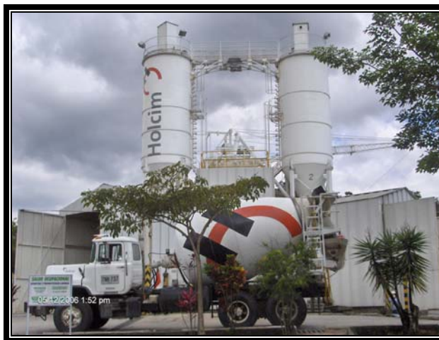
FOTO 1. Planta de mezclados Holcim.
