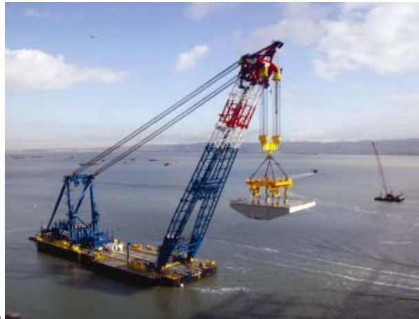
Figura C-6. Izado de dovelas transportadas en barcasas mediante piernas de cortante
