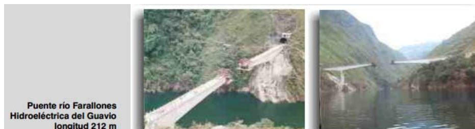
Figura 11. Puente sobre el río Farallones, Cundinamarca.
