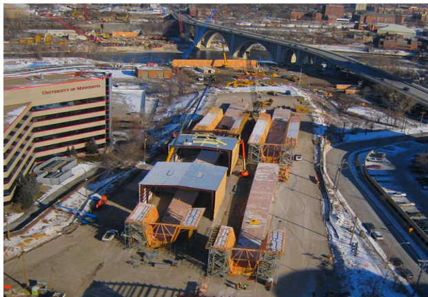
Figura C-1. Planta de prefabricación de segmentos (Casting's Yard).
