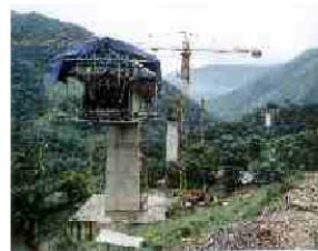
(4) Construcción de una pila.
