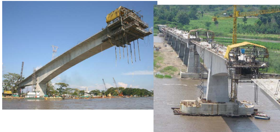
Figura 16. Puente de Barranca-Yondó sobre el Río Magdalena sobre el Estrecho Galán.
