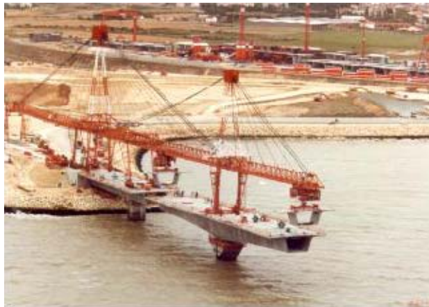
Figura C-8. Izado de dovelas mediante viga lanzada soportada por tirantes.
