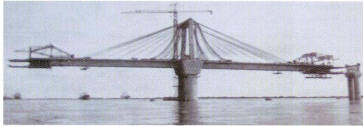
Puente en construcción sobre el río Magdalena en Barranquilla
