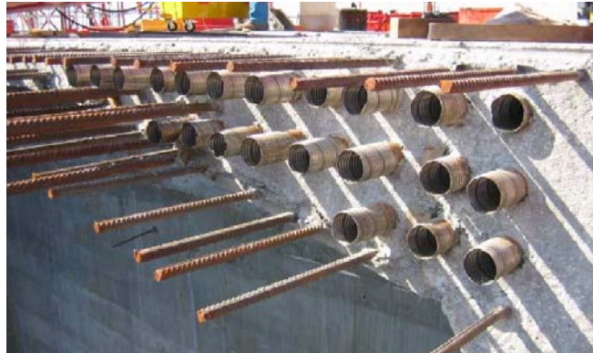
Figura B-2. Ductos vacíos en la cartela superior.
