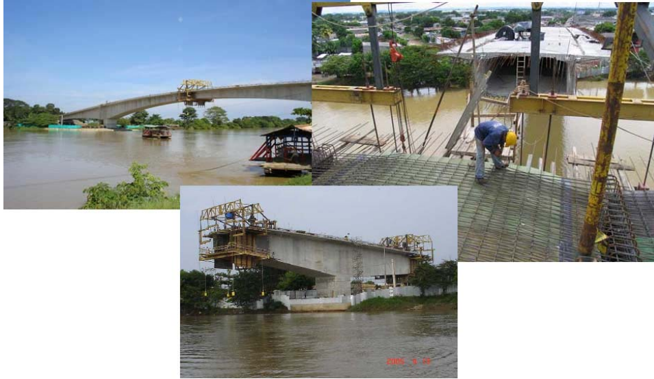
Figura 17. Puente sobre el río Sinú, Montería.
