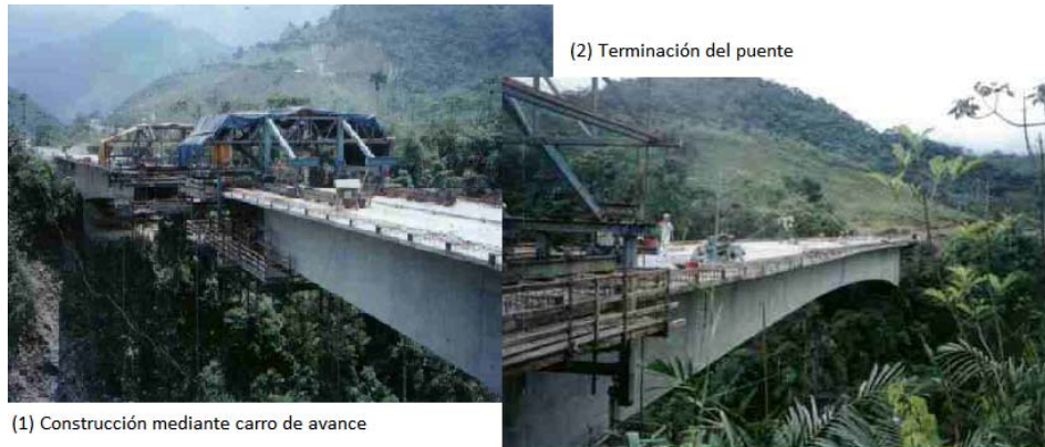
Figura 15. Puente de Sevitá, Autopista Bogotá-Villavicencio.
