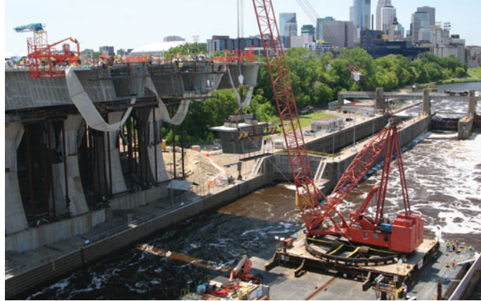
Figura C-5. Izado de dovelas mediante grúa montada sobre una barcaza.
