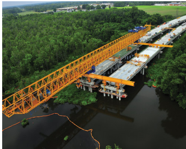
Figura A-3. Sistema de grúa-pórtico lanzable. Esquemmatización del método de luz a luz.
