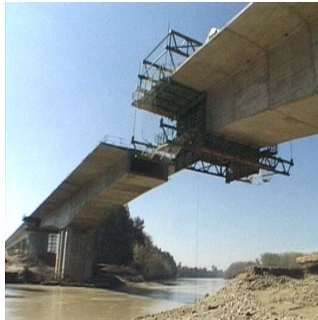
Figura B-3. Dovela de cierre para el viaducto sobre el Rio Guadalquivir.
