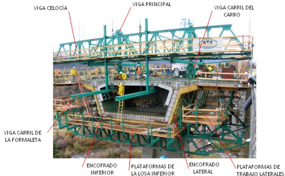
Figura B-1. Esquema de un carro móvil tradicional con vigas principales situadas encima de la losa superior.
