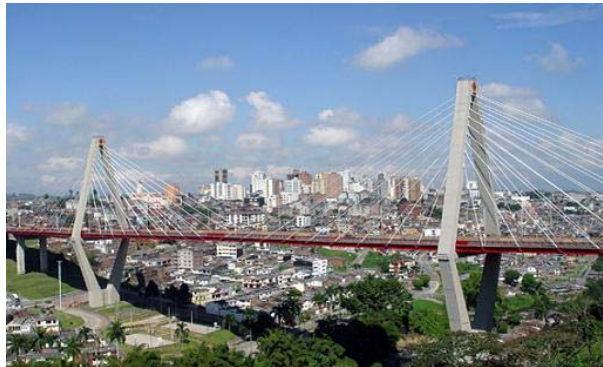
Figura 12. Puente del viaducto Pereira-Dos Quebradas, Risaralda
