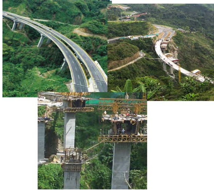
Figura 18. Viaducto La Estampilla. Carretera Pereira-Manizales
