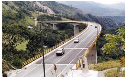
(1) Puente Pipiral en Servicio
