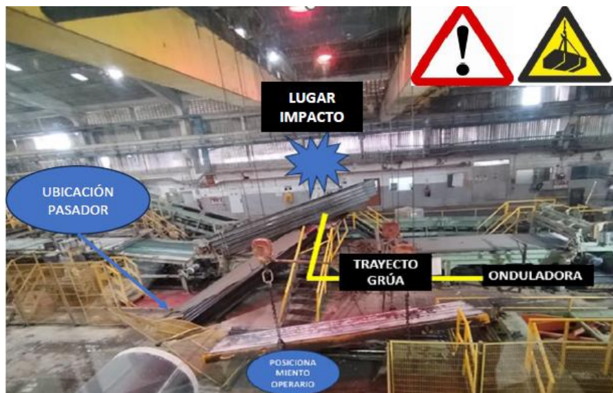
Figura. 1 Incidente de Grúa. 1
