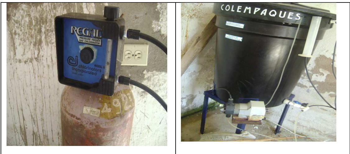
Fotos caseta de inspección
