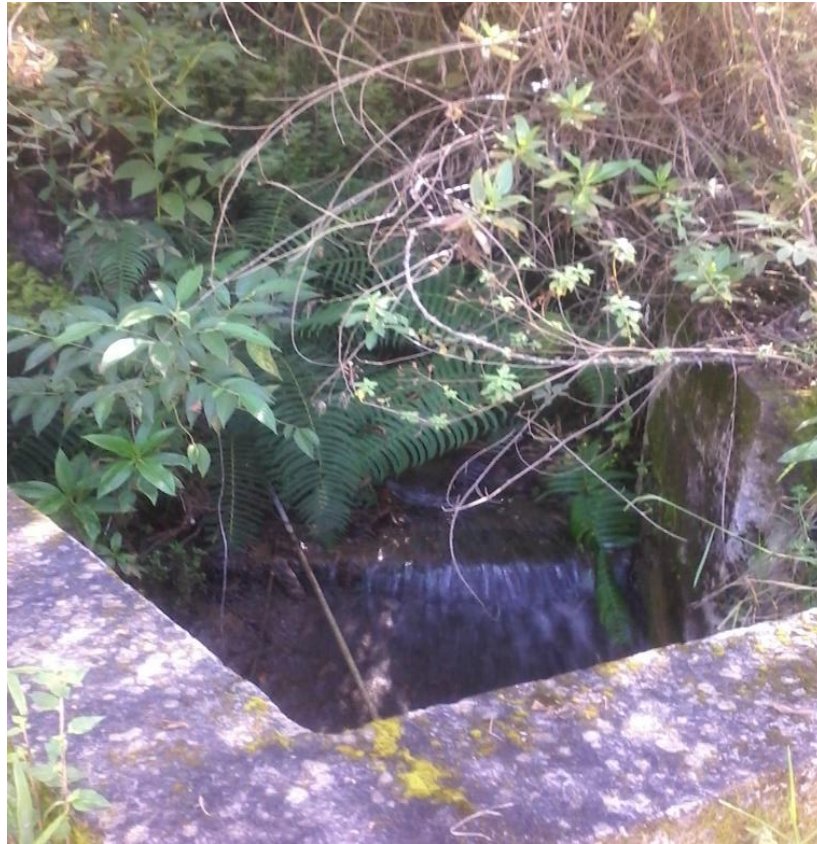
Apéndice 24. Cuneta de la Quebrada el Tejar al cruce con la carretera.
