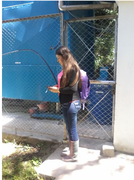
Apéndice 28. Tanque de almacenamiento y tratamiento de agua, Quebrada el Tejar.
