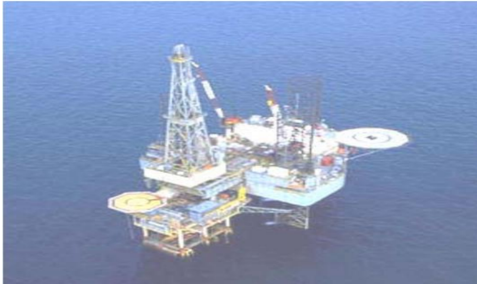
Figura 47. Plataforma fija con floating drilling tender
