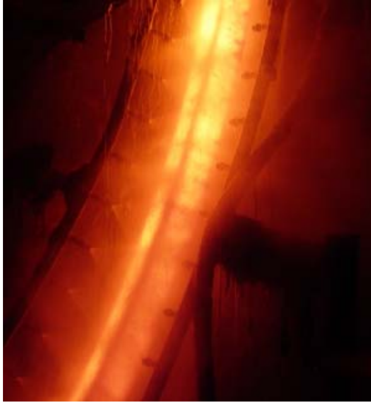
Figura 26. Zona 2 de refrigeración.
