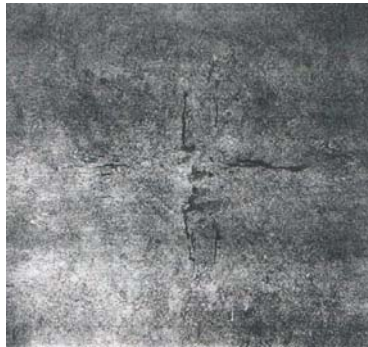
Figura 13. Grieta estrella, en palanquilla.
