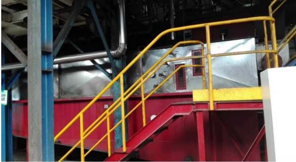
Tanque preclarificador de Entrepalmas SAS
