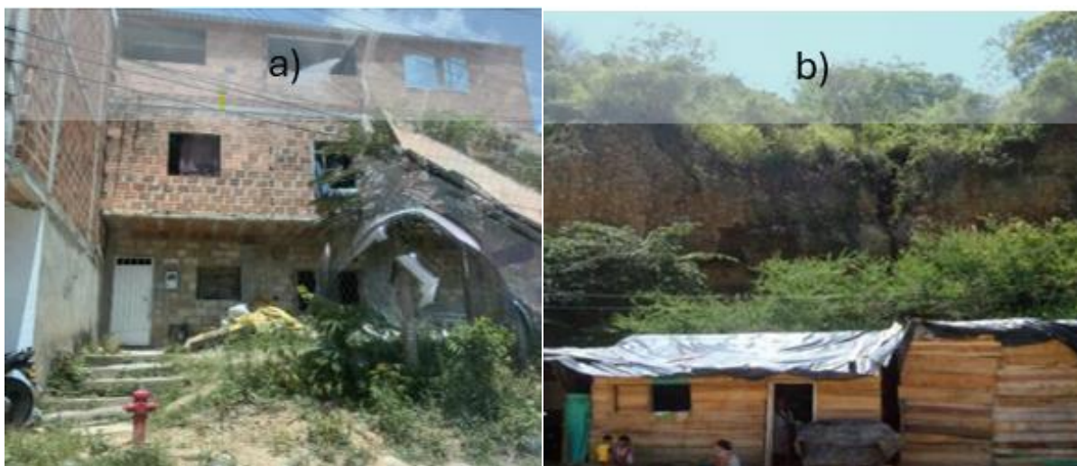
Figura 4 Materiales utilizados en la construcción de viviendas informales: a) Barrio Cristal Bajo. b) Asentamiento Rincón de la paz.
