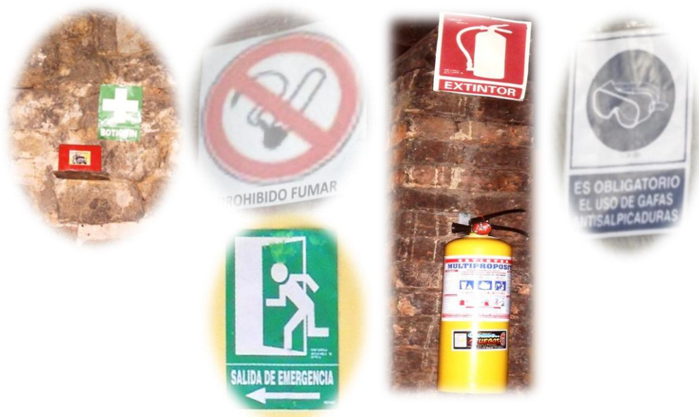
Figura 27. Botiquín, extintor y señalización dentro del trapiche la esperanza
