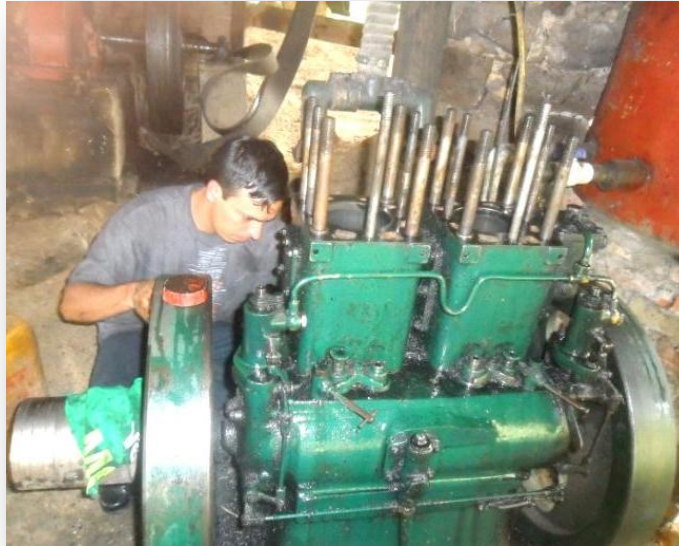
Figura 36. Mantenimiento del motor y hornilla del trapiche
