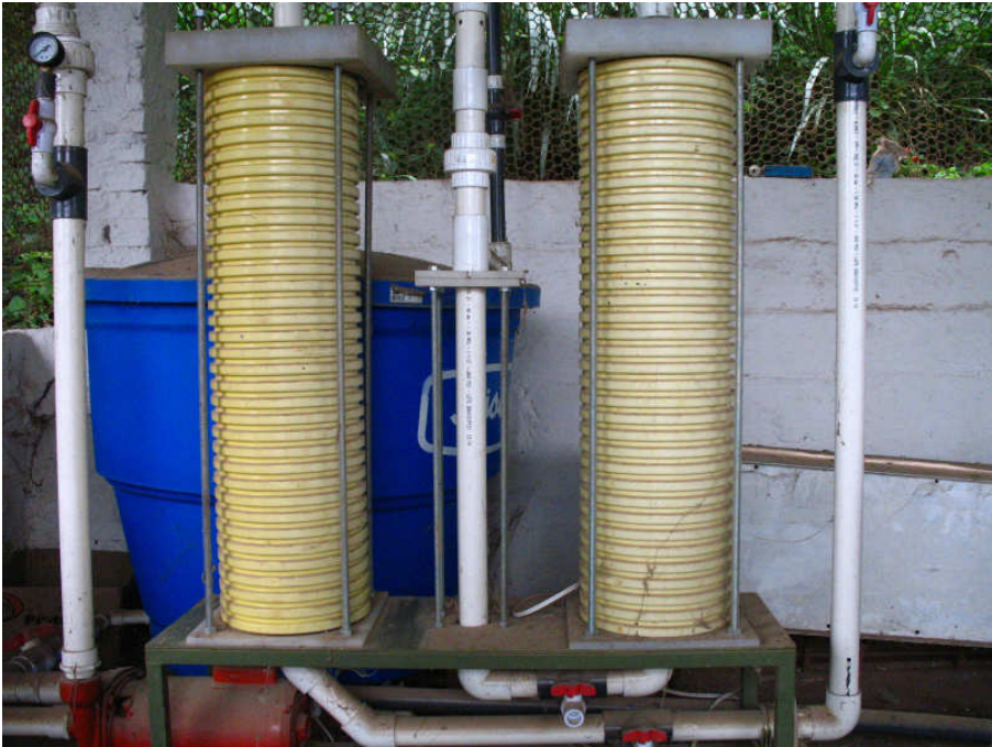
Batería de filtros bolsa y filtro germicida UV
