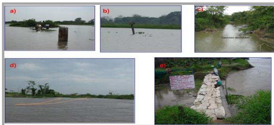
Figura 20. Desbordamiento de cuerpos de Agua a) y b) Talanquera Km 72+000,c) Rio Simaña Km 12+000, d) Sector Venecia Km 74+500 al 76+500 y e) Km 143+107 Puerto Camajón. .
