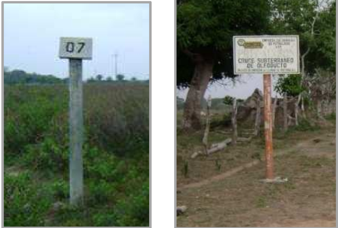
Figura 24. Postes de Abscisado y vallas de señalización.
