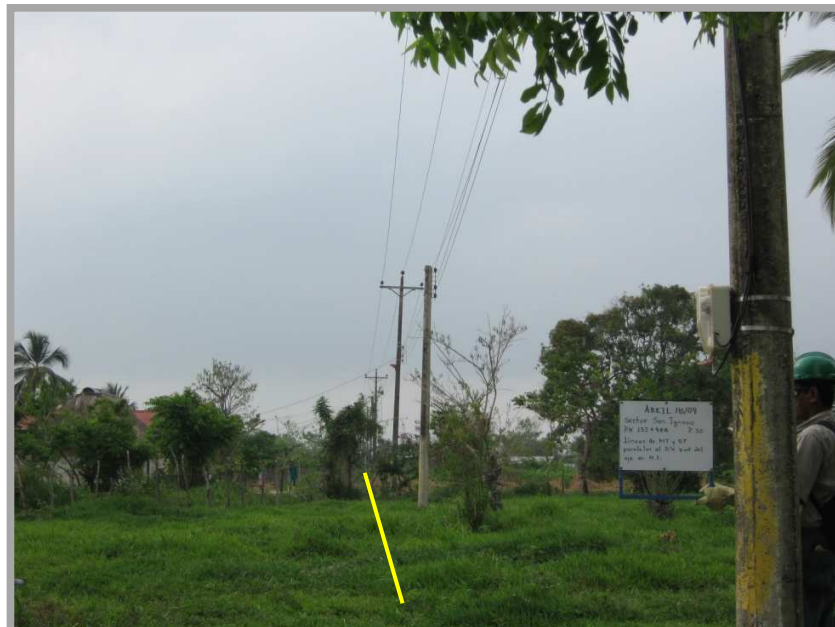
Figura 26. Paralelismo con líneas de Media Tensión Km 152+986.
