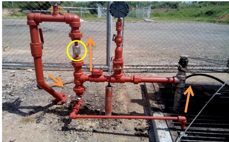
→ Dirección del flujo de gas de anular      ○ Válvula choque
