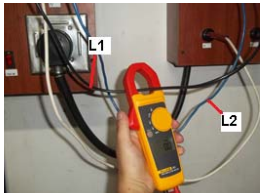
Figura 11. Medir voltaje entre líneas.
