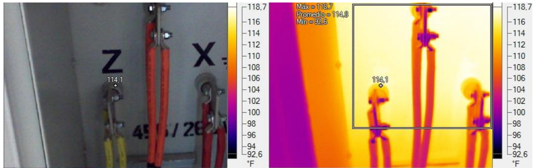
Figura 32. Transformador Trifásico de 225 kVA.
