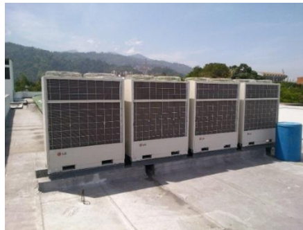
Figura 45. Incidencia Solar en las Unidades Condensadoras
