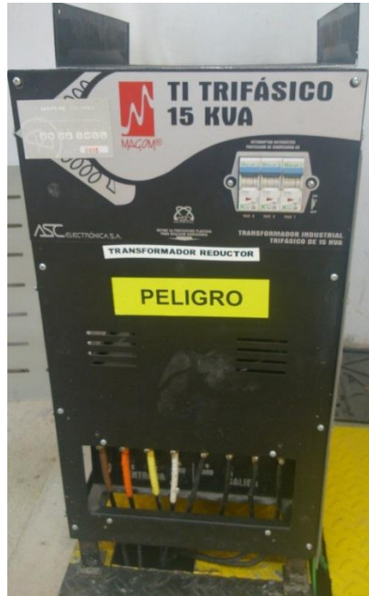
Figura 4. Transformador #3, 15 kVA.
