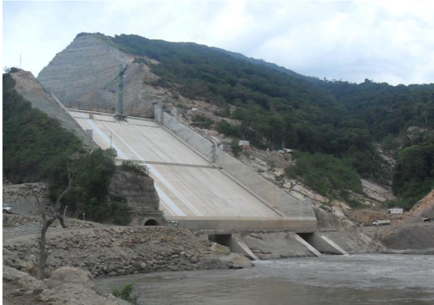
Figura 43. Proyecto Hidroeléctrico Sogamoso
