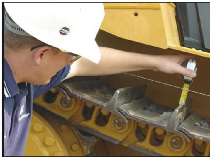
Figura 62. Medición de la tensión de la Cadena
