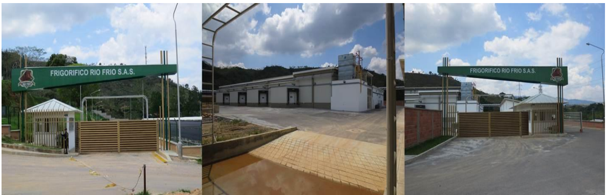
Figura 2. Instalaciones Planta Ecológica de Beneficio Animal Río Frío S.A.S.
