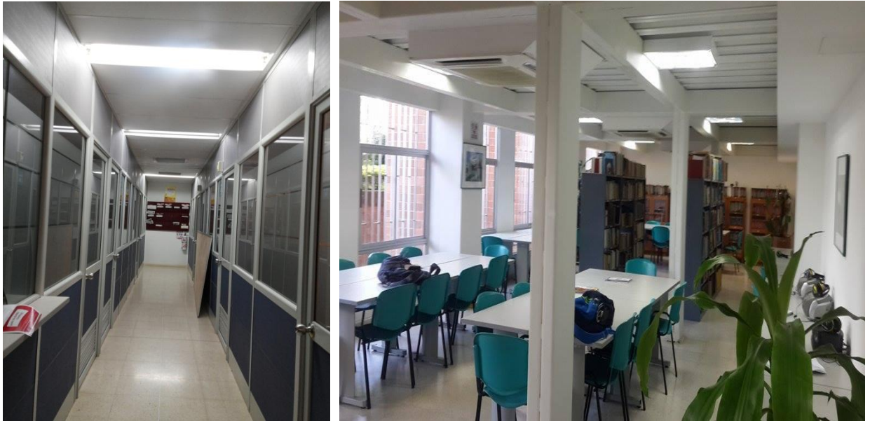
Figura 40. Pasillos sin sensor y salas sin aprovechamiento de luz natural.
