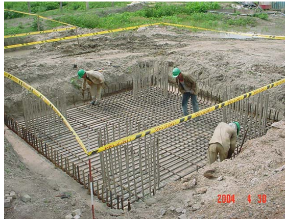
Figura 2. Armada de aceros para zapata.
