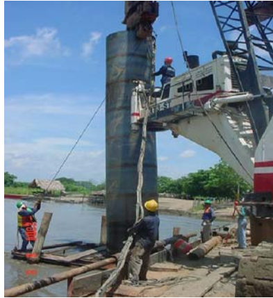
Figura 25. Piloteadora hincando la camisa.
