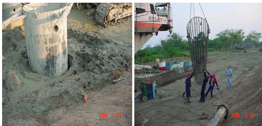
Figuras 12 y 13. Hinca de camisa. Desplazamiento de las canastas.
