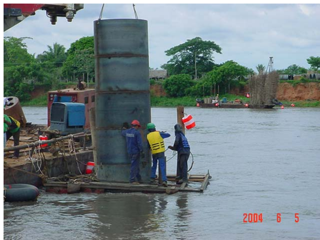
Figura 3. Camisa conformada por tramos soldados
