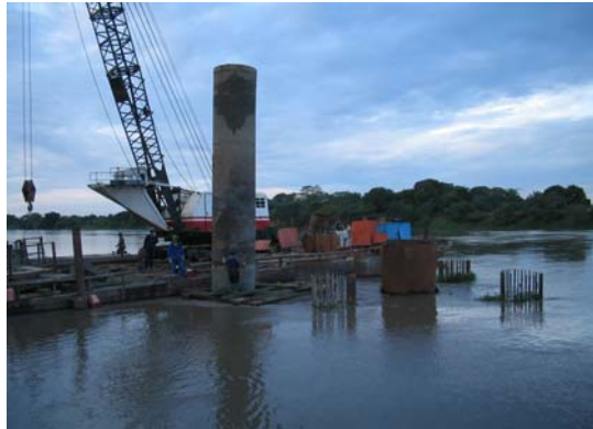
Figura 24. Piloteadora montada sobre un ferry.
