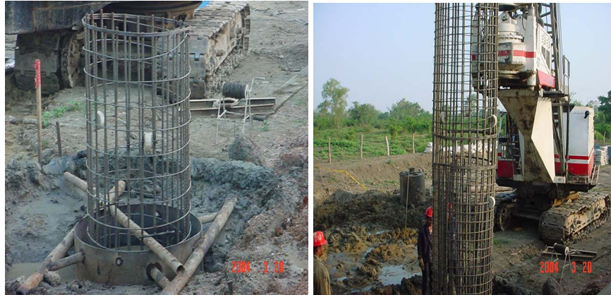
Figuras 14 y 15. Canasta ya colocada en el sitio. Traslapo de canastas.
