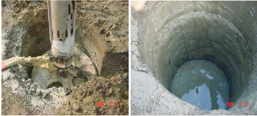
Figuras 10 y 11. Martillo. Martillo en proceso de hinca de la camisa.
