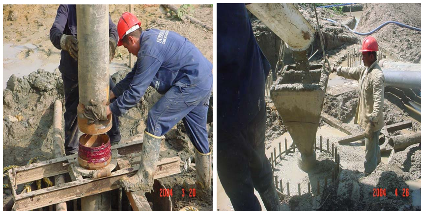
Figuras 18 y 19. Instalación de tubería tremie. Vaciado del concreto en el pilote.
