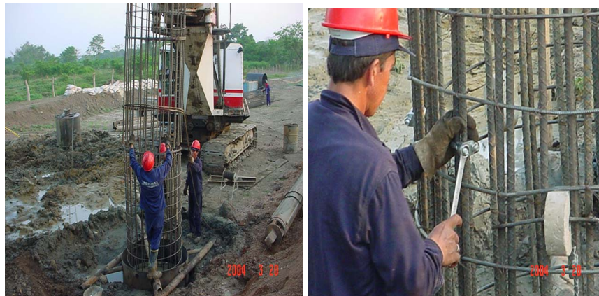
Figuras 18 y 19. Instalación de tubería tremie. Vaciado del concreto en el pilote.
