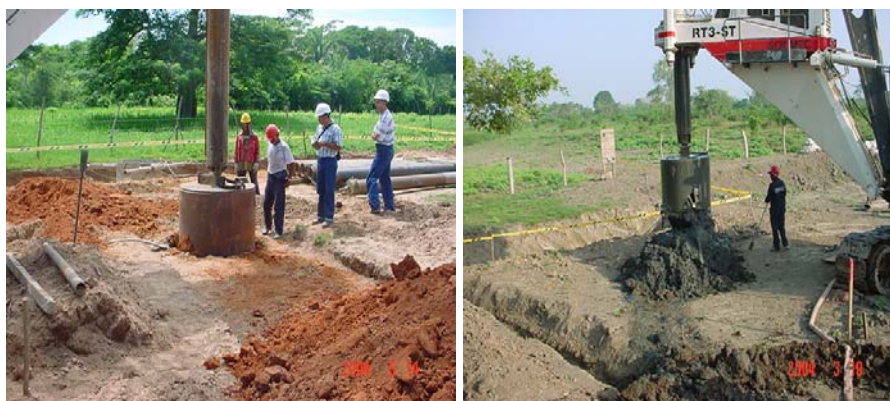
Figuras 6 y 7. Piloteadora excavando el suelo. Extracción del material.
