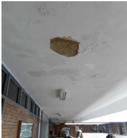
Humedad Placa cuarto piso costado occidental, (Edificio LL)
