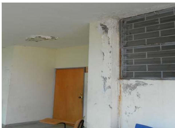
Humedad pasillo cuarto piso (Edificio LL) – Laboratorios de Física (Construidos en 2006)
